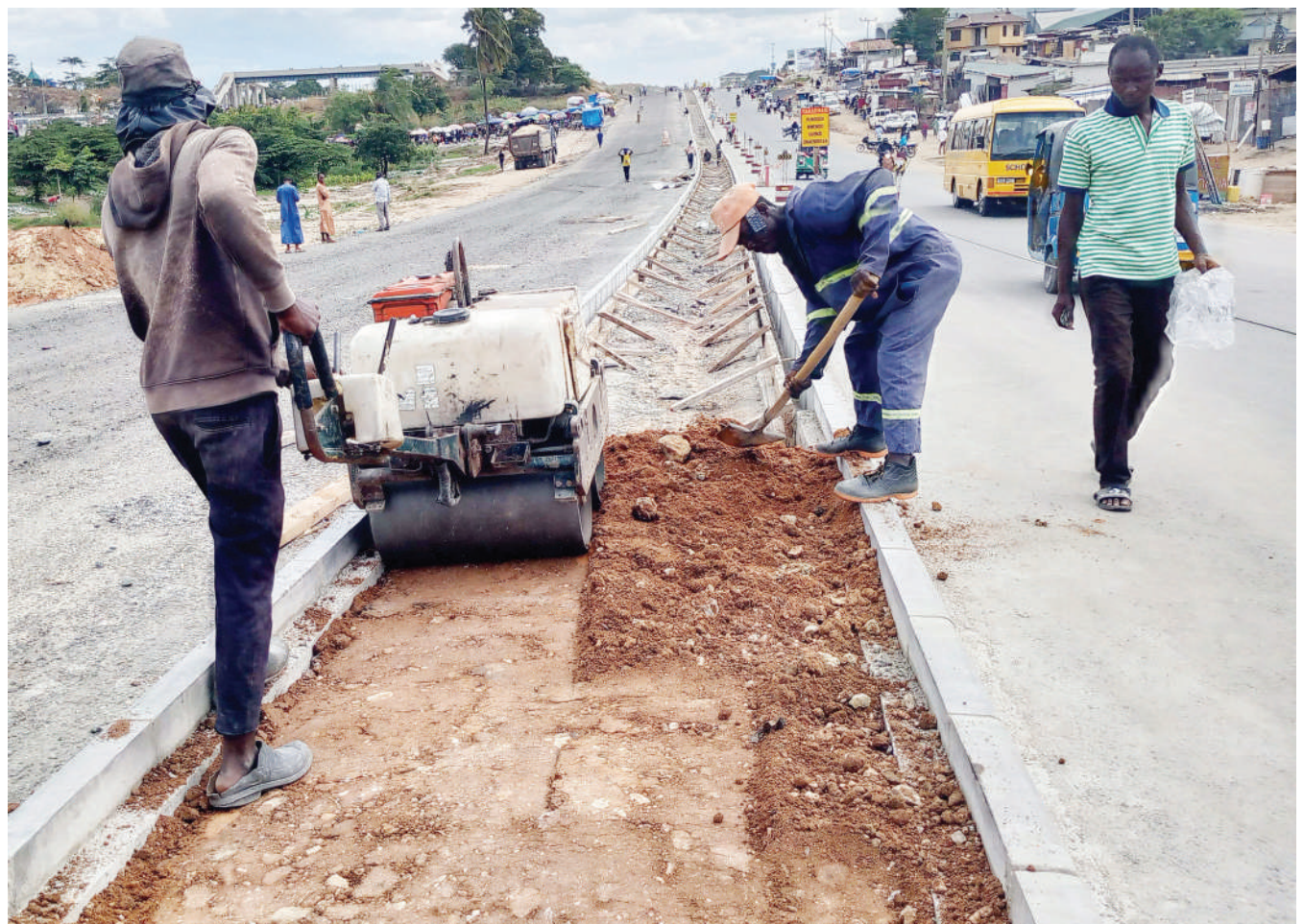
Mafundi wakisawazisha na kushindilia udongo katika bustani inayotenganisha barabara mpya ya kuelekea stendi kuu ya Magufuli Mbezi Luis, Manispaa ya Ubungo Dar es Salaam jana, ambayo imepanuliwa na kuwa na sehemu mbili, ili kupunguza msongamano wa mabasi. PICHA: SABATO KASIKA
