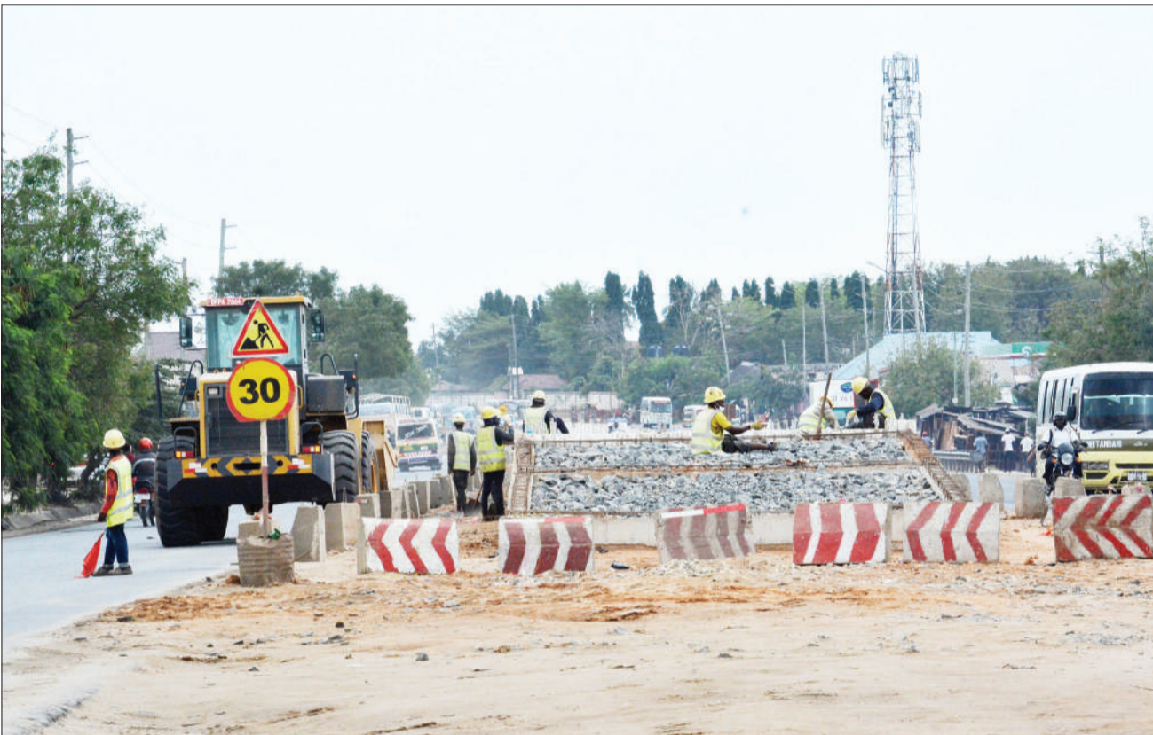
Mafundi wakijenga kituo cha mabasi ya mwendokasi katika mradi unaoendelea wa ujenzi wa miundombinu ya mabasi hayo katika barabara ya Kilwa eneo la Mbagala Zakhem, jijini Dar es Salaam jana. PICHA: MIRAJI MSALA
