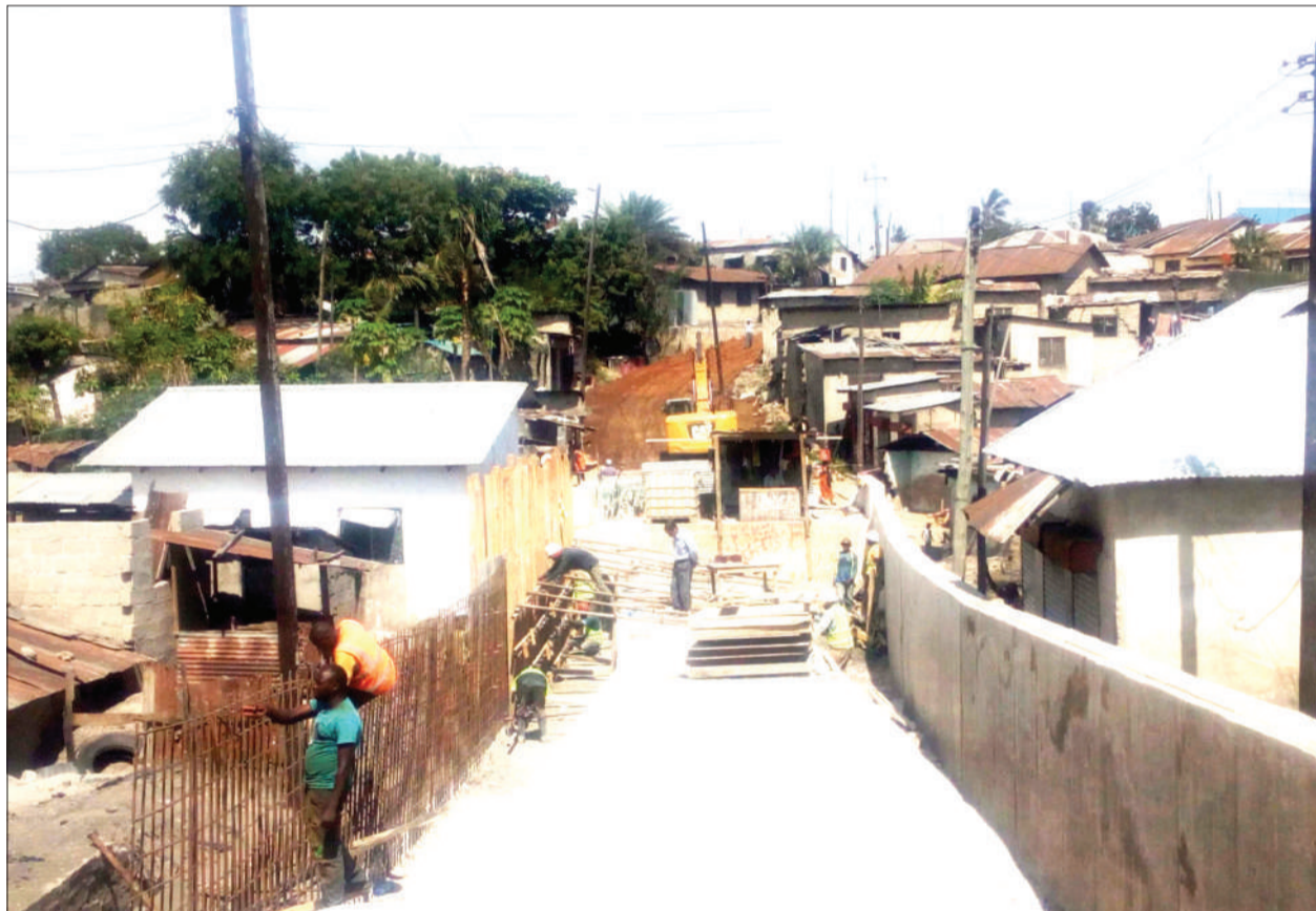
Mafundi wakiendelea na ujenzi wa daraja linalounganisha maeneo ya Kata ya Keko Magurumbasi na Keko Mwanga, jijini Dar es Salaam mwishoni mwa wiki, ili kuwaondolea wananchi changamoto ya kukosekana kwa mawasiliano ya barabara wakati wa mvua. PICHA: SABATO KASIKA
