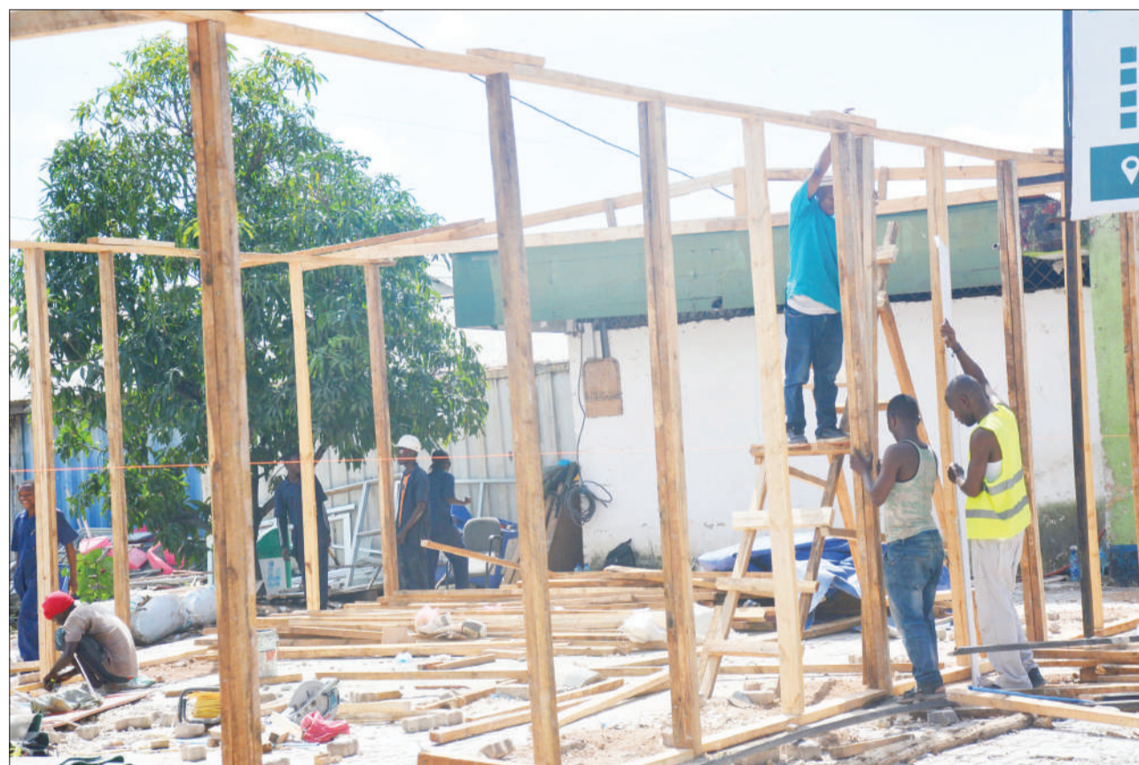
Mafundi wakiendelea na ujenzi wa mabanda ya biashara ikiwa ni maandalizi ya Maonyesho ya Biashara ya Kimataifa (Sabasaba) katika viwanja vya Mwalimu Nyerere, Barabara ya Kilwa, jijini Dar es Salaam jana. PICHA: JUMANNE JUMA
