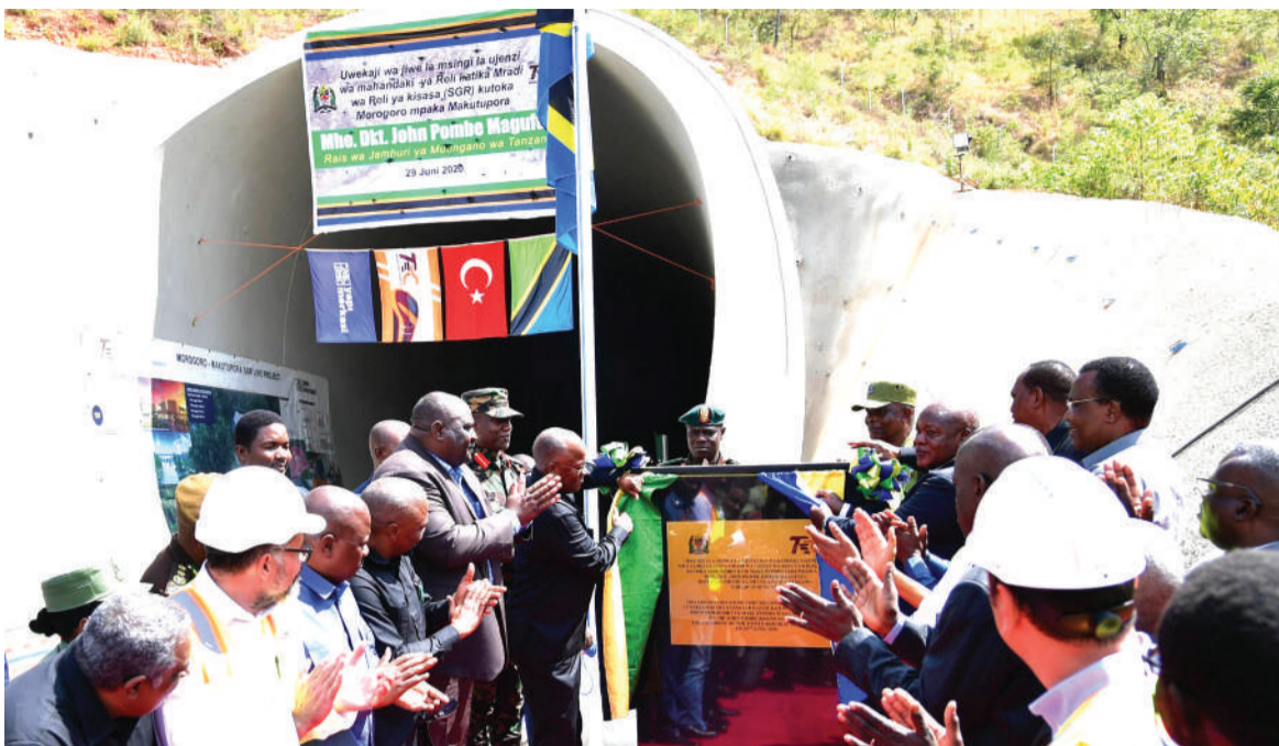
Rais John Magufuli akiwa na Waziri wa Ujenzi, Uchukuzi na Mawasiliano, Isack Kamwelwe na viongozi mbalimbali akiweka jiwe la msingi la ujenzi wa mahandaki ya reli ya kisasa (SGR) katika eneo la Kilosa mkoani Morogoro, jana. PICHA: IKULU
