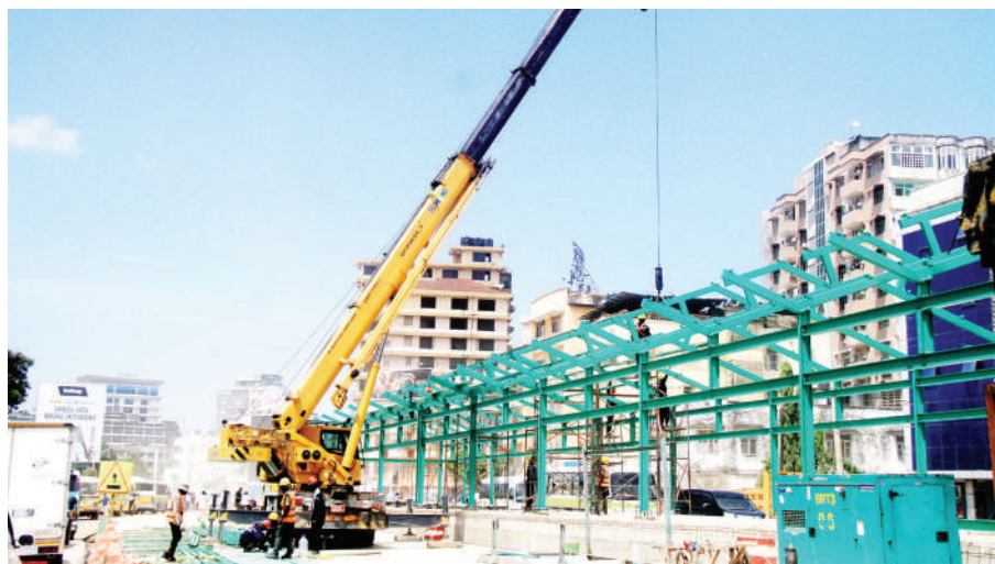
Mafundi wa kam-puni ya ujenzi ya mkandara-si, wakien-delea na ujenzi wa Kituo cha mabasi yaendayo haraka cha Mnazi Mmoja, jijini Dar es Salaam jana. PICHA: JUMANNE JUMA
