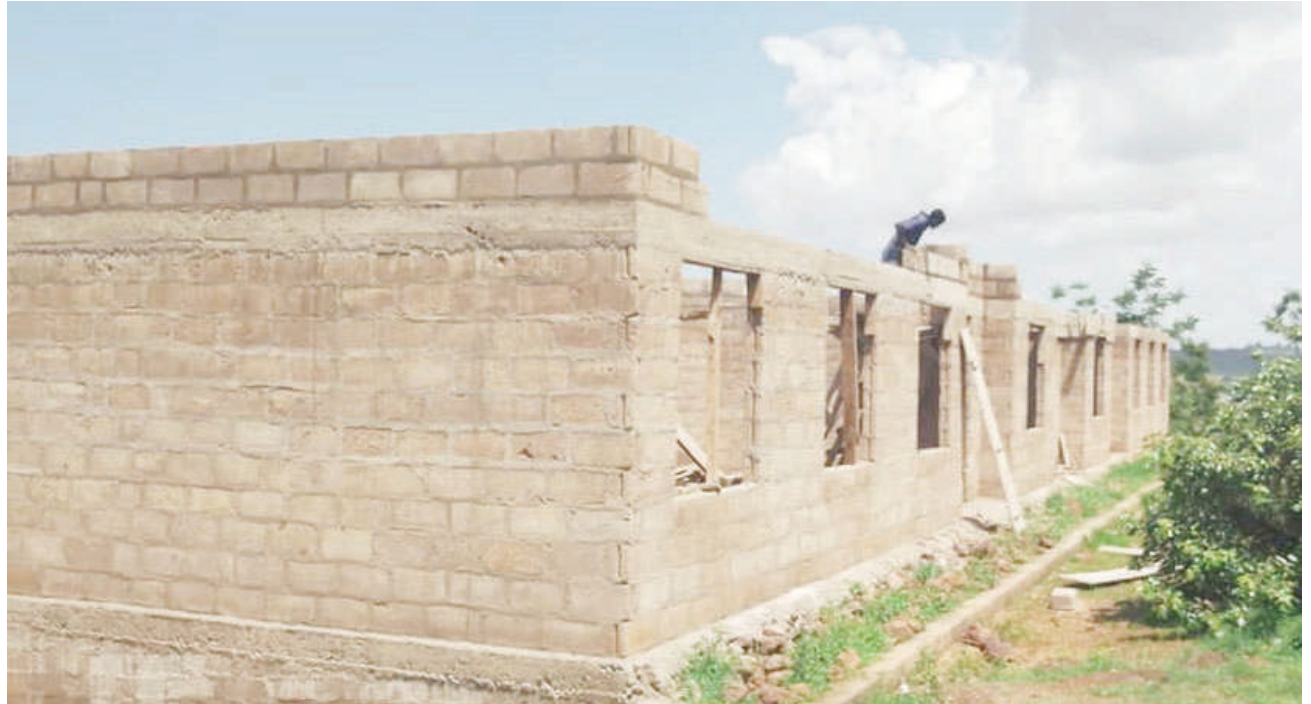
Fundi akiendelea na ujenzi wa jengo la maabara ya masomo ya sayansi, kwenye Shule ya Sekondari Mtiro katika kijiji cha Busekera, Kata ya Bukumi, Musoma Vijijini mkoani Mara, jana. PICHA: MPIGAPICHA WETU
