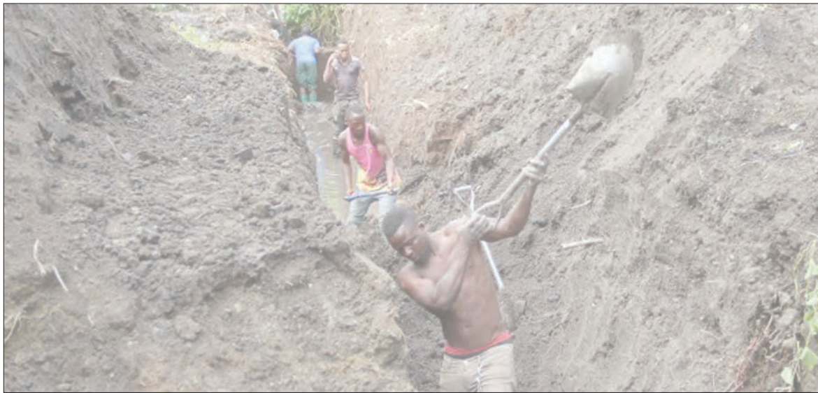
Baadhi ya mafundi wa Mamlaka ya Maji Safi na Usafi wa Mazingira Mkoa wa Mbeya (Mbeya-UWASA), wakichimba mtaro wa kusafirisha maji machafu kwenye chanzo cha maji cha Nzovwe jana, ili kukiboresha na kufikisha maji kwenye Kata za Isyesye na Itezi. PICHA: NEBART MSOKWA
