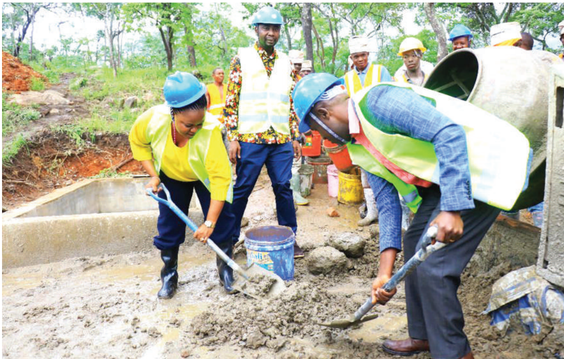
Naibu Waziri wa Maji, Mhandisi Maryprisca Mahundi (kushoto) na Mkurugenzi Mkuu wa Wakala wa Usambazaji Maji Vijijini (RUWASA), Mhandisi Clement Kivegalo, wakishiriki kuchanganya zege kwa ajili ya ujenzi wa tangi la kuhifadhi maji kwenye Mradi wa Bwawa la Maji la Matwiga, wilayani Chunya. PICHA ZOTE: NEBART MSOKWA.
