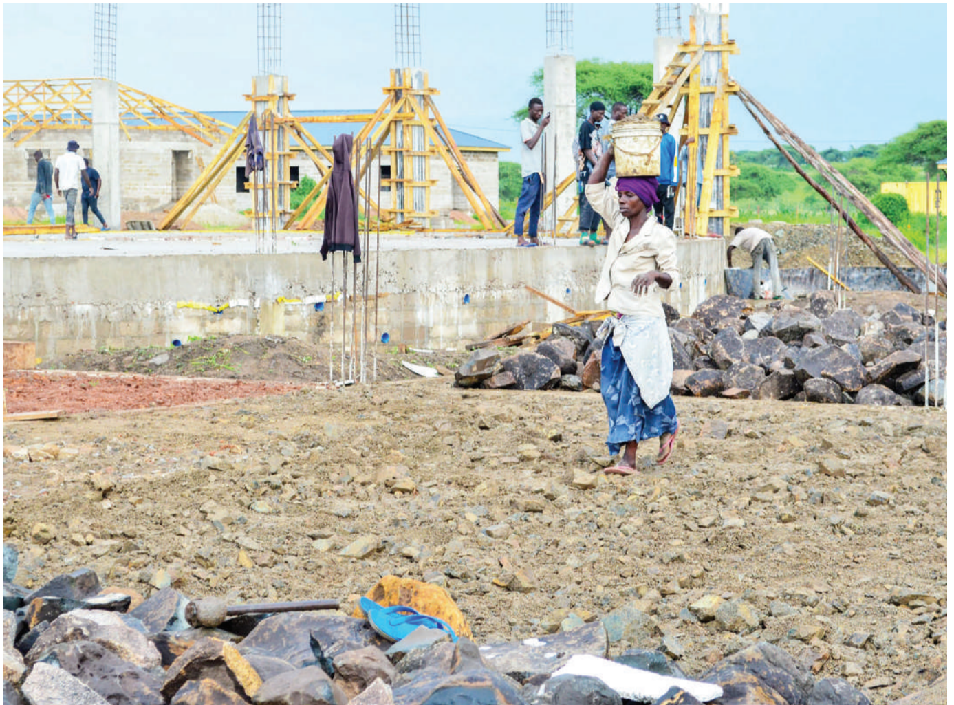
Wananchi wakishiriki ujenzi wa sekondari ya wasichana ya masomo ya sayansi mkoa wa Mara, inayojengwa eneo la Bulamba jimbo la Mwibara juji. Kwa sasa serikali inajenga sekondari za aina hiyo kila mkoa ikiwa ni njia ya kuwahamasisha wanafunzi kusoma masomo hayo. PICHA: MPIGAPICHA WETU
