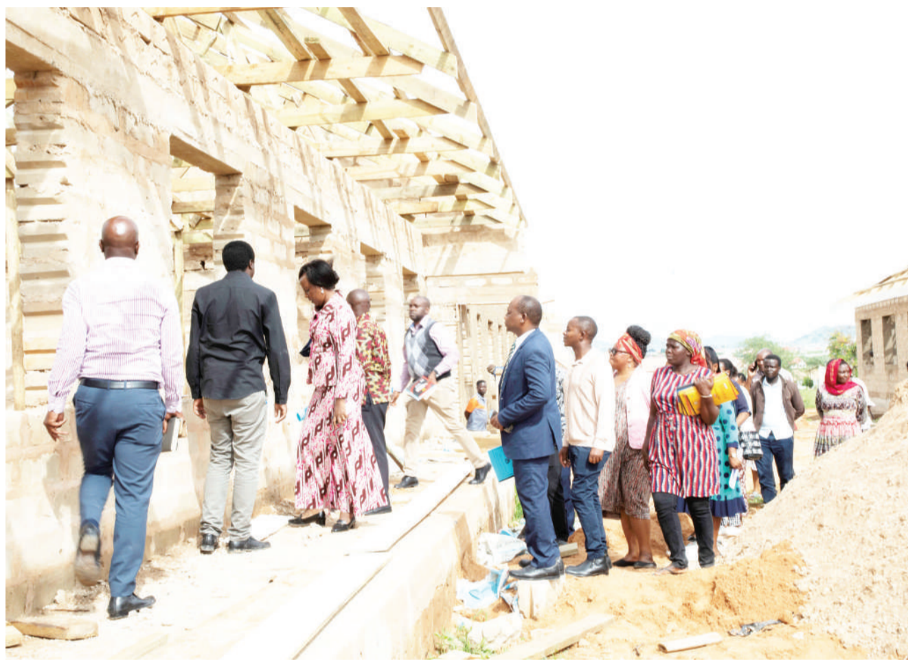
Mkuu wa Mkoa wa Dodoma, Rosemary Senyamule ( wa tatu kutoka kushoto) akikagua ujenzi wa shule mpya ya Sekondari ya Michese, inayojengwa kata ya Mkonze katika Jiji la Dodoma jana, wengine kutoka kushoto ni Kaimu Ofisa Elimu wa Sekondari Jiji, Nicodemous Kileo na Mhandisi wa Jiji la Dodoma, Fredy Mwakisambwe. PICHA: PETER MKWAVILA
