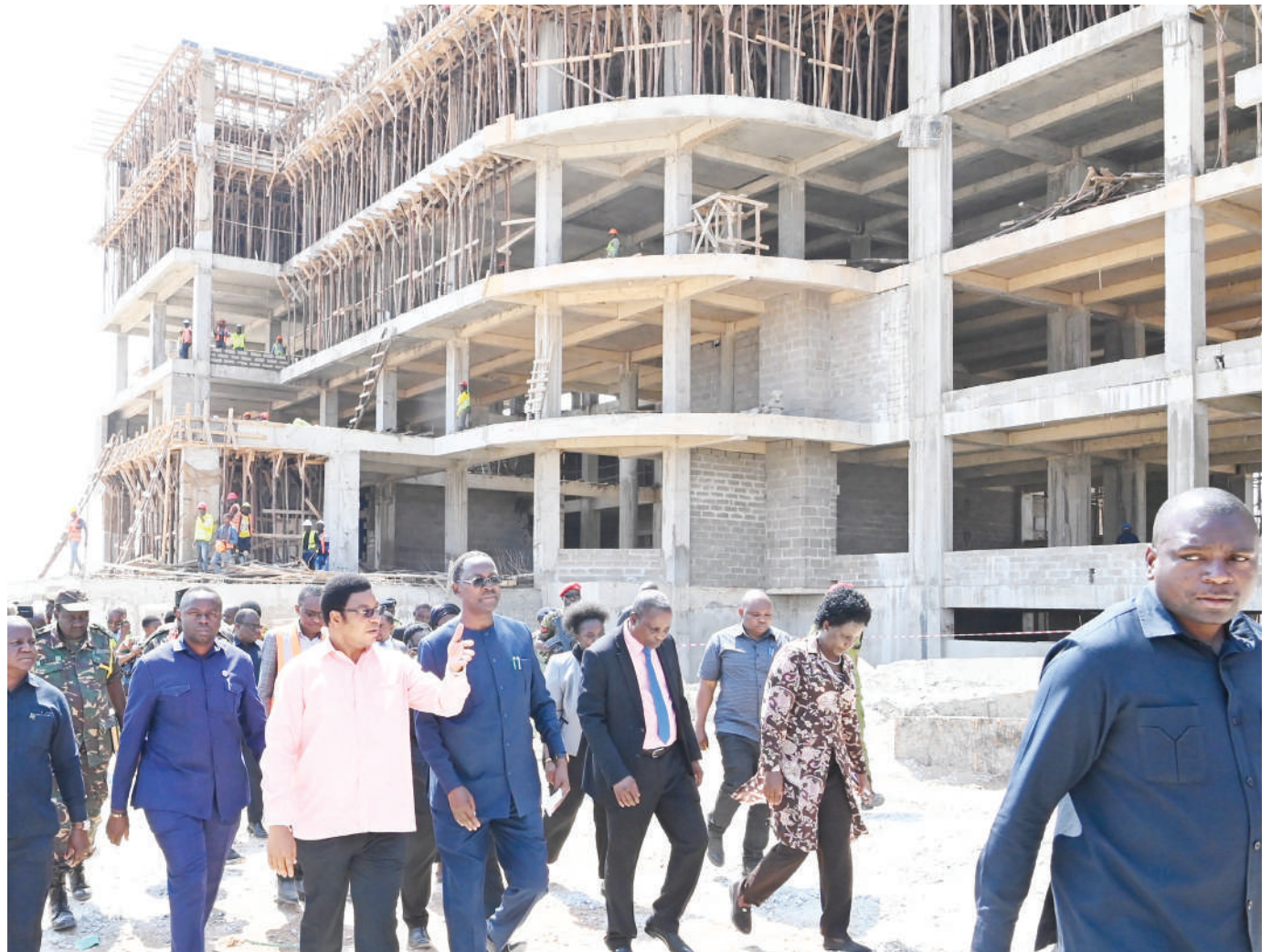
Waziri Mkuu, Kassim Majaliwa, akikagua jengo la Ofisi ya Waziri Mkuu-Sera, Bunge na Uratibu, wakati alipokagua maendeleo ya ujenzi wa majengo ya wizara mbalimbali katika Mji wa Serikali-Mtumba, Dodoma juzi. PICHA: OFISI YA WAZIRI MKUU
