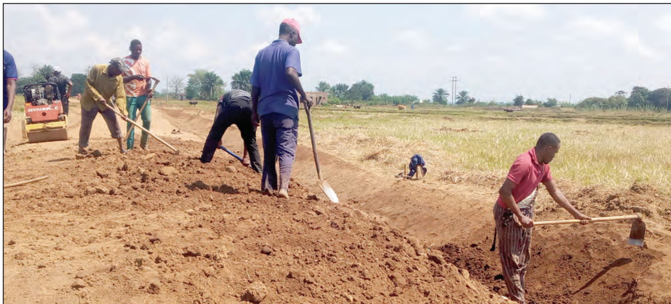
Wanafunzi wa Taasisi ya Teknolojia ya Ujenzi Mbeya (ICot) wakiendelea na ujenzi wa barabara katika Kata ya Kajunjumele kuelekea katika mwalo wa Kafyofyo iliyoko Wilaya ya Kyela mkoani Mbeya juzi. PICHA: GRACE MWAKALINGA
