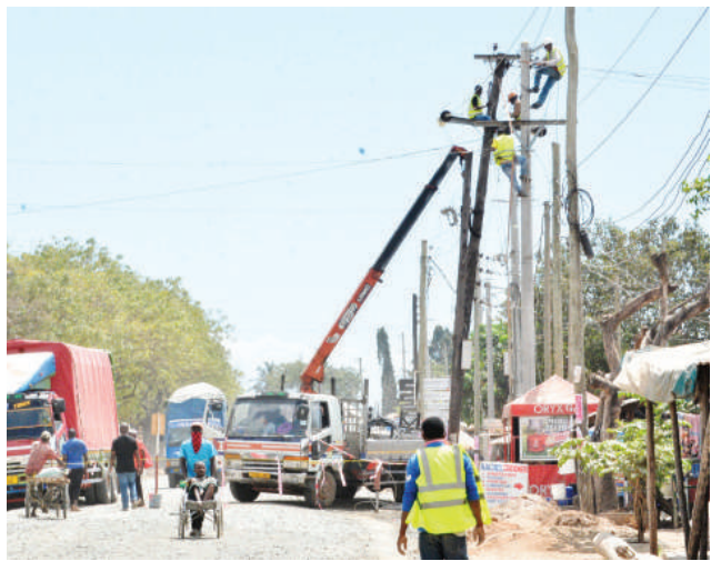
Mafundi wa Shirika la Umeme nchini (TANESCO), wakihamisha nguzo za umeme ili kupisha ujenzi unaoendelea wa barabara katika eneo la Chuo cha Taifa cha Usafirishaji (NIT), Mabibo mkoani Dar es Salaam jana. PICHA: MIRAJI MSALA
