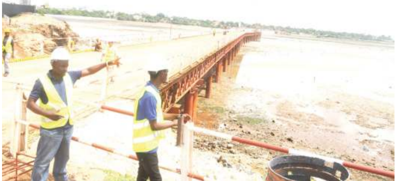
Mhandisi kutoka Kampuni ya CRMBEG, Godwin Kambuga (kushoto), akifafanua jambo kwa waandishi wa habari jijini Dar es Salaam jana, kuhusu ujenzi wa daraja la muda kwa ajili ya maandalizi ya ujenzi wa daraja jipya la Selander katika eneo la Seaview Upanga. PICHA: JOHN BADI
