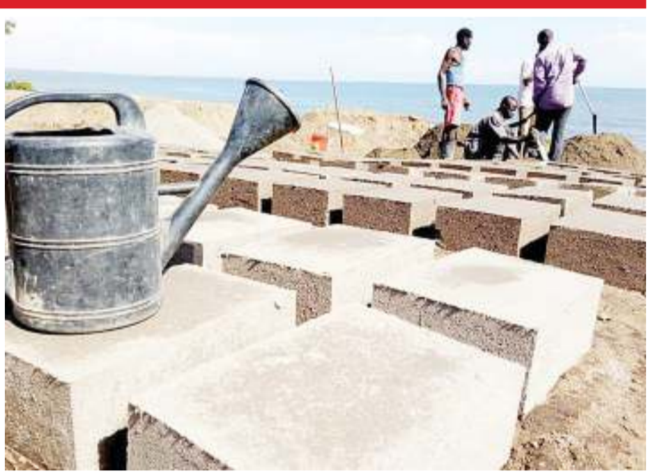
Mafundi wakifyatua matofali kwa ajili ya ujenzi wa jengo la maabara la Shule ya Sekondari Murangi, katika Jimbo la Musoma Vijijini mkoani Mara jana, ikiwa ni mwendelezo wa uboreshaji wa maabara za masomo ya sayansi kwenye sekondari za kata, jimboni humo. PICHA: MPIGAPICHA WETU
