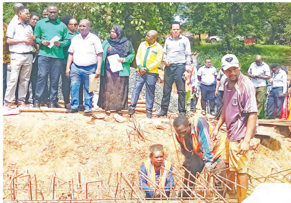
Mjumbe wa Kamati ya Siasa ya CCM Mkoa wa Tanga, Omari Ayubu (wa pili kushoto), aki-kagua ujenzi wa daraja jipya katika Mto Amtico, kata ya Genge Kwamtiga, akiwa ziara yake ya siku mbili ya kukagua miradi ya maendeleo wilayani Muheza jana. Wa (sita kushoto) ni Katibu Tawala wilaya ya Muheza, Mohamed Mfaki. PICHA: STEVEN WILLIAM
