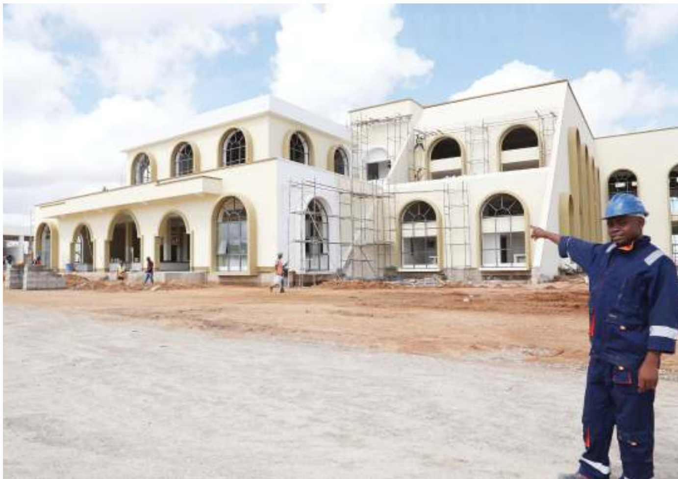
Mhandisi Nassiri Nassoro wa kampuni ya ujenzi ya Mohammed Builders Ltd, akionyesha hatua ya ujenzi wa mradi wa Soko Kuu la Dodoma ilipofikia jana, mradi huo upo eneo la Nzuguni jijini humo na unatarajiwa kukamilika Februari 2020. PICHA NA IBRAHIM JOSEPH
