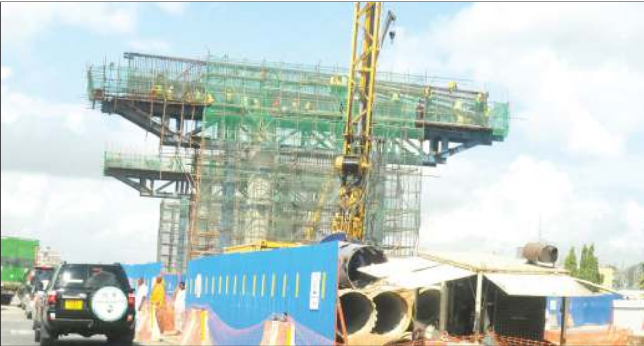
Mafundi wakiendelea na ujenzi wa barabara za juu "interchange", katika makutano ya Barabara ya Mandela, Morogoro na Sam Nujoma, katika eneo la Ubungo, jijini Dar es Salaam jana. PICHA: JOHN BADI
