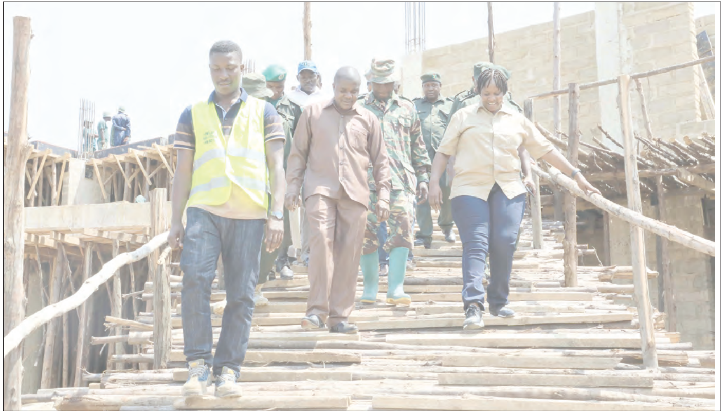
Naibu Waziri wa Maliasili na Utalii, Mary Masanja (kulia), akiwa anashuka kwenye hoteli ya nyota 3 ya Shirika la Hifadhi za Taifa Tanzania (TANAPA) inayojengwa wilayani Chato mkoani Geita, ikiwa ni ziara ya kikazi mkoani humo. Katikati ni Mkuu wa Wilaya ya Chato, Charles Kabeho. PICHA:MPIGAPICHA WETU
