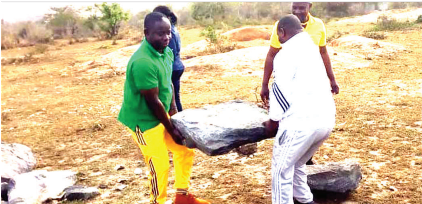
Katibu Tawala wa Wilaya ya Handeni mkoani Tanga, Mashaka Mgeta (kushoto), akisaidiana na Diwani wa Kata ya Kwenjugo wilayani humo, Twaha Mgaya, kwa ajili ya ujenzi wa madarasa ya shule shikizi ya Koloja juji. PICHA: MPIGAPICHA WETU
