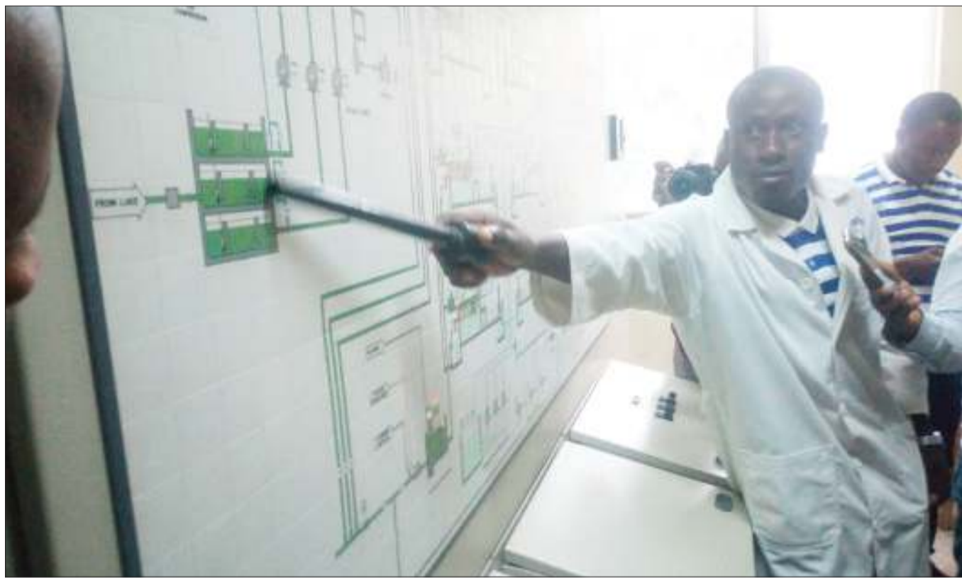
Mtaalamu wa maabara ya Mwauwasa kutoka katika kituo cha tiba ya maji Capripoint, Yusuph Bunzali, akionyesha muundo wa namna maji yanavyoanza kuingia kwenye matangi na kufanyiwa tiba kwa kuwekwa dawa mpaka kumfikia mtumiaji yakiwa safi na salama kwa matumizi. PICHA NA ELIZABETH FAUSTINE
