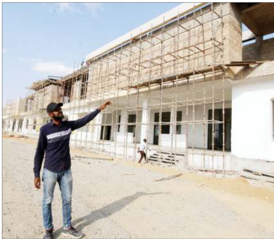
Mhandisi Idrisa Noorane wa Kampuni ya Ujenzi ya Mohammed Builder akiwaonyesha waandishi wa habari (hawapo pichani) maendeleo ya ujenzi wa mradi wa kituo kikuu cha mabasi jijini Dodoma, ujenzi huo unatekelezwa na kampuni hiyo na awamu ya kwanza inatarajiwa kukamilika mwezi Septemba mwaka huu. PI-CHA: IBRAHIMU JOSEPH
