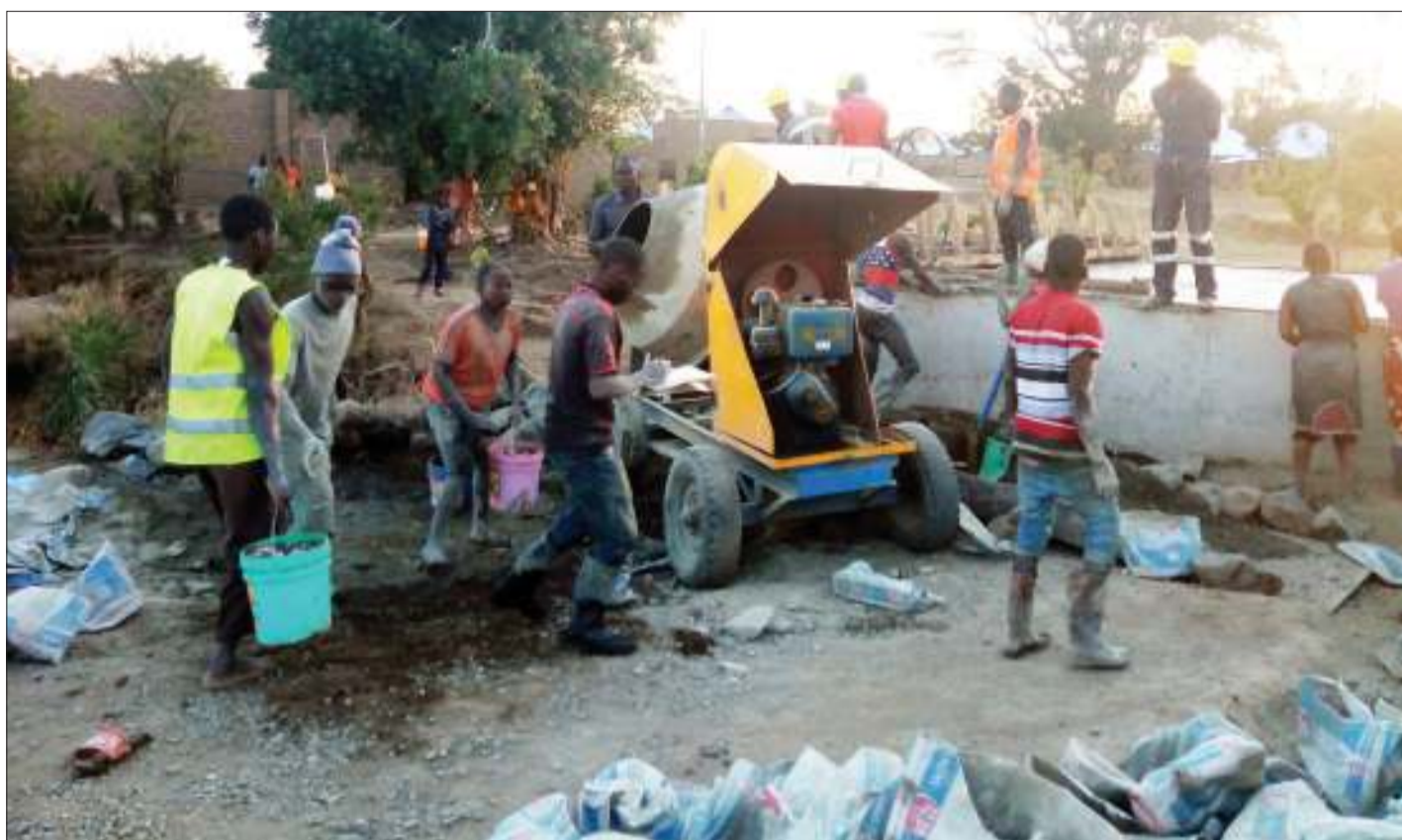
Mafundi wakiendelea na ujenzi wa moja ya madaraja katika Mamlaka ya Mji Mdogo wa Mbalizi, mkoani Mbeya jana, ikiwa ni sehemu ya mikakati ya serikali kuimarisha miundombinu ya barabara. PICHA: NEBART MSOKWA
