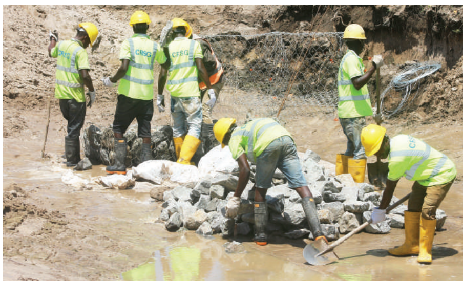
Mafundi wa kampuni ya ujenzi ya China Railway Seventh Group, wakipanga mawe kwa ajili ya kujenga ukingo wa maji katika eneo la Chang'ombe Dar es Salaam jana. PICHA: JUMANNE JUMA
