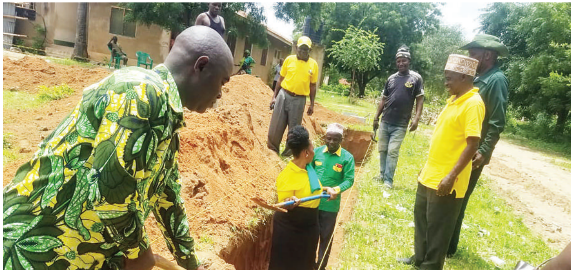
Viongozi na wanachama wa Chama Cha Mapinduzi (CCM), Wilaya ya Liwale, mkoani Lindi, wakichimba msingi juzi, kwa ajili ya ujenzi wa ukumbi wa kisasa, ambao ni mmoja ya miradi ya kimkakati ya kukuza uchumi wa chama hicho. PICHA: MPIOGAPICHA WETU
