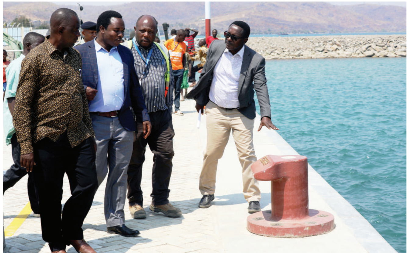
Kaimu Meneja wa Bandari za Ziwa Tanganyika, Edward Mabula, akimwonesha Naibu Waziri wa Uchukuzi, Atupele Mwakibete, baadhi ya miundombinu ya bandari iliyokamilika, alipotembelea mradi wa ujenzi wa Bandari ya Karema mkoani Katavi. PICHA: MPIGAPICHA WETU
