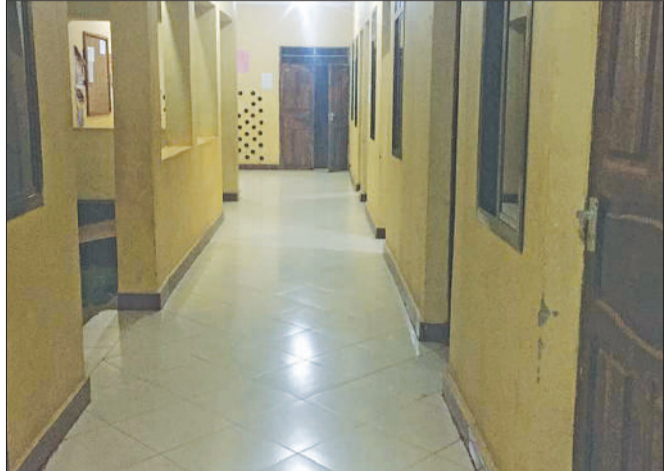
Mwonekano wa ndani wa Zahanati ya Rwakaremera baada ya kupata nishati ya umeme. PICHA: SHABAN NJIA
