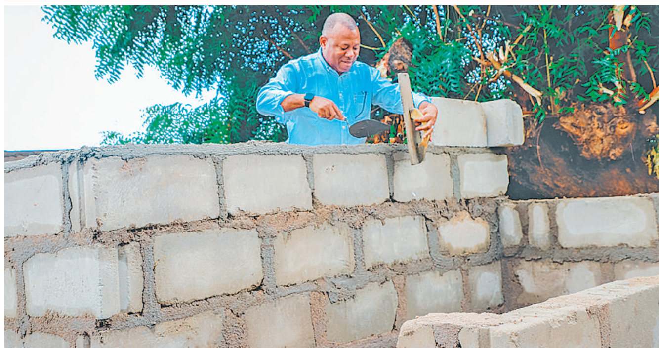
Mkuu wa Wilaya ya Dodoma, Alhaji Jabir Shekimweri, akiwasaidia mafundi alipotembelea kukagua maendeleo ya ujenzi wa Shule ya Sekondari ya Kata ya Matumburu, jijini Dodoma juzi. PICHA: PETER MKWAVILA
