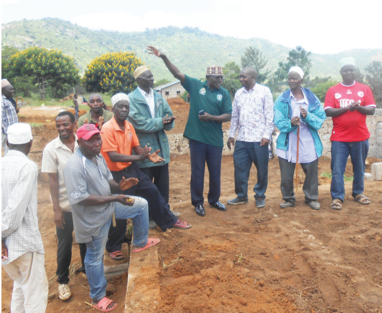
Diwani wa Kata ya Songe, Wilaya ya Kilindi, Mkoa wa Tanga, Mohamed Makengwa (wanne kulia) akitoa maelezo kwa Ofisa Elimu Sekondari, Wilaya ya Kilindi, Ntuli Mwakabungu (wa tatu kulia) alipotembelea mradi wa ujenzi wa madarasa ya kidato cha nne na tano yanayojengwa Shule ya Sekondari Seuta kwa gharama ya zaidi ya Sh. milioni 400. Wa pili kulia ni Mwenyekiti wa Kamati ya Ujenzi, Ally Mbwege na wengine ni wajumbe wa kamati hiyo. PICHA: DEGE MASOLI
