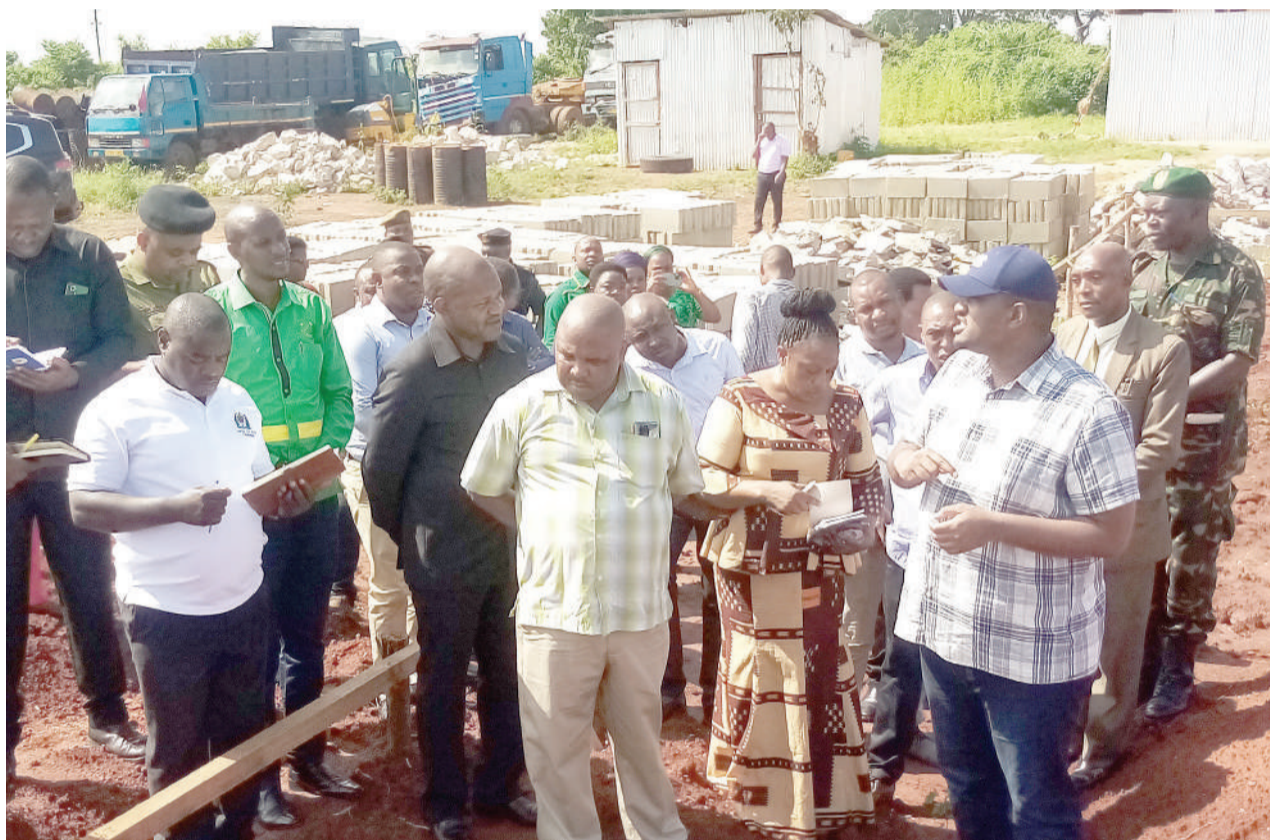
Naibu Waziri Ofisi ya Rais (TAMISEMI), Deo Ndejemi (kulia), akitoa maelekezo alipotembelea mradi wa ujenzi wa jengo jipya la utawala la Halmashauri ya Muheza jana na kukagua mradi wa Shule ya Msingi Magila, Shule ya Sekondari ya Chatuu na ujenzi wa Shule ya Sekondari Makole. Picha: STEVEN WILLIAM
