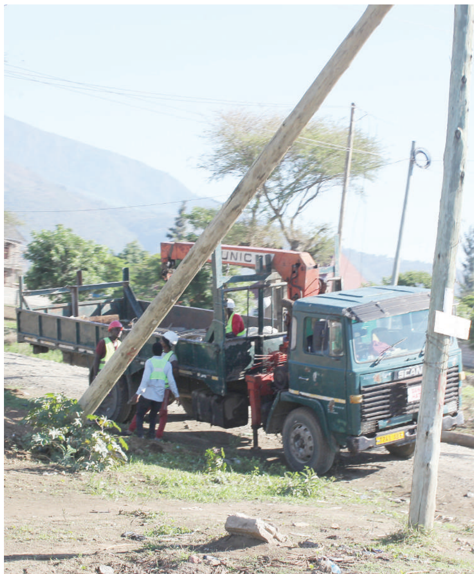
Wafanyakazi wa Shirika la Umeme nchini (TANESCO) Mkoa wa Mbeya wakijiandaa kufanya kazi ya kuhamisha nguzo za umeme ili kupisha utekelezaji wa mradi wa ujenzi wa barabara ya njia nne katika eneo la Iwambi jijini Mbeya jana. PICHA: NEBART MSOKWA
