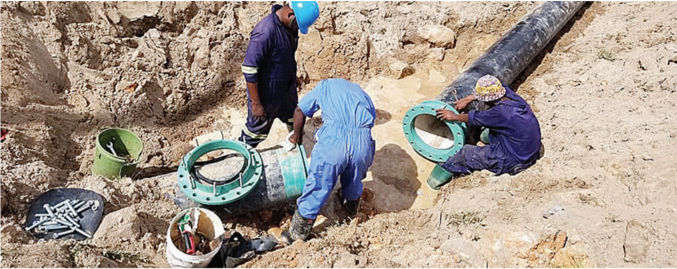
Mafundi wa Mamlaka ya Majisafi na Usafi wa Mazingira, Dar es Salaam (Dawasa), wakiendelea na ulazaji wa mabomba katika mradi wa maji wa Buza wenye lengo la kupeleka huduma ya maji kwa wakazi wa Jeti na Buza hadi Mwanagati. Kazi hiyo inatarajiwa kukamilika mwezi ujao. PICHA: MPIGAPICHA WETU.
