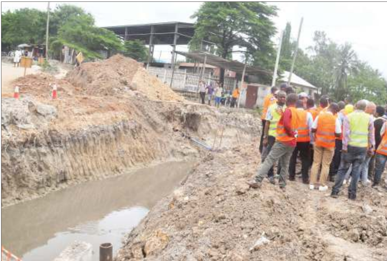
Timu ya wajumbe kutoka Manispaa za Dar es Salaam, Wakala wa Barabara za Vijijini na Mijini (TARURA) na Benki ya Dunia (WB), wakikagua mradi wa upanuzi na ujenzi wa kingo za Mto Ng'ombe, unaotekelezwa kupitia Mradi wa DMDP, chini ya fedha za mkopo nafuu wa benki hiyo, katika eneo la mpaka wa Kijitonyama na Tandale uzuri jijini humo, juzi. PICHA: JOHN BADI
