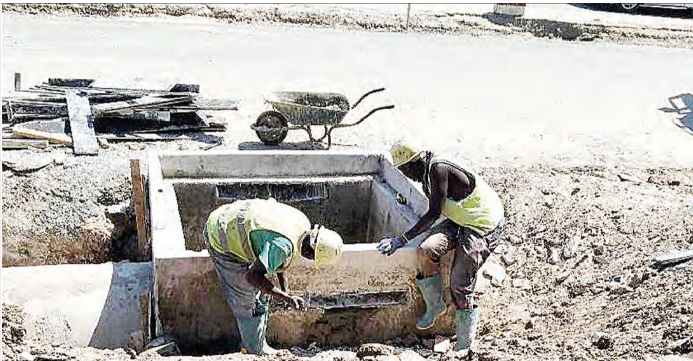
Mafundi wakiendelea na matengenezo ya chemba ya maji ya mvua katika ukarabati unaoendelea wa Barabara ya Shekilango, eneo la Sinza Madukani, jijini Dar es Salaam jana. Picha: JOSEPH MWENDAPOLE
