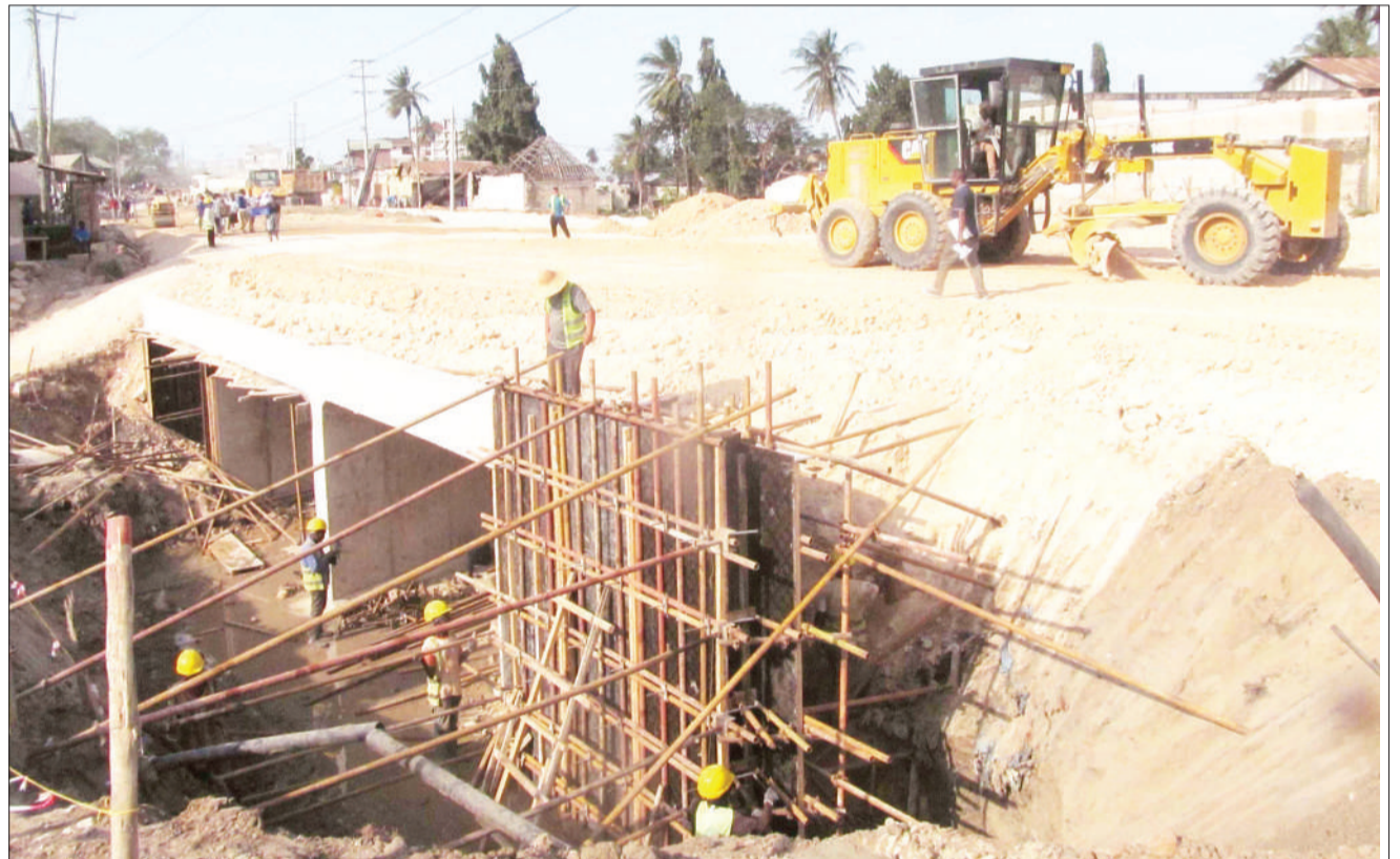
Kazi ya ujenzi wa daraja kubwa katika barabara ya Shekilango eneo la Legho ikiendelea jijini Dar es Salaam jana, ambapo likikamilika huenda likamaliza kero ya maji kujaa na kupita juu wakati wa msimu wa mvua na kusababisha mawasiliano ya barabara kukatika. PICHA: SABATO KASIKA
