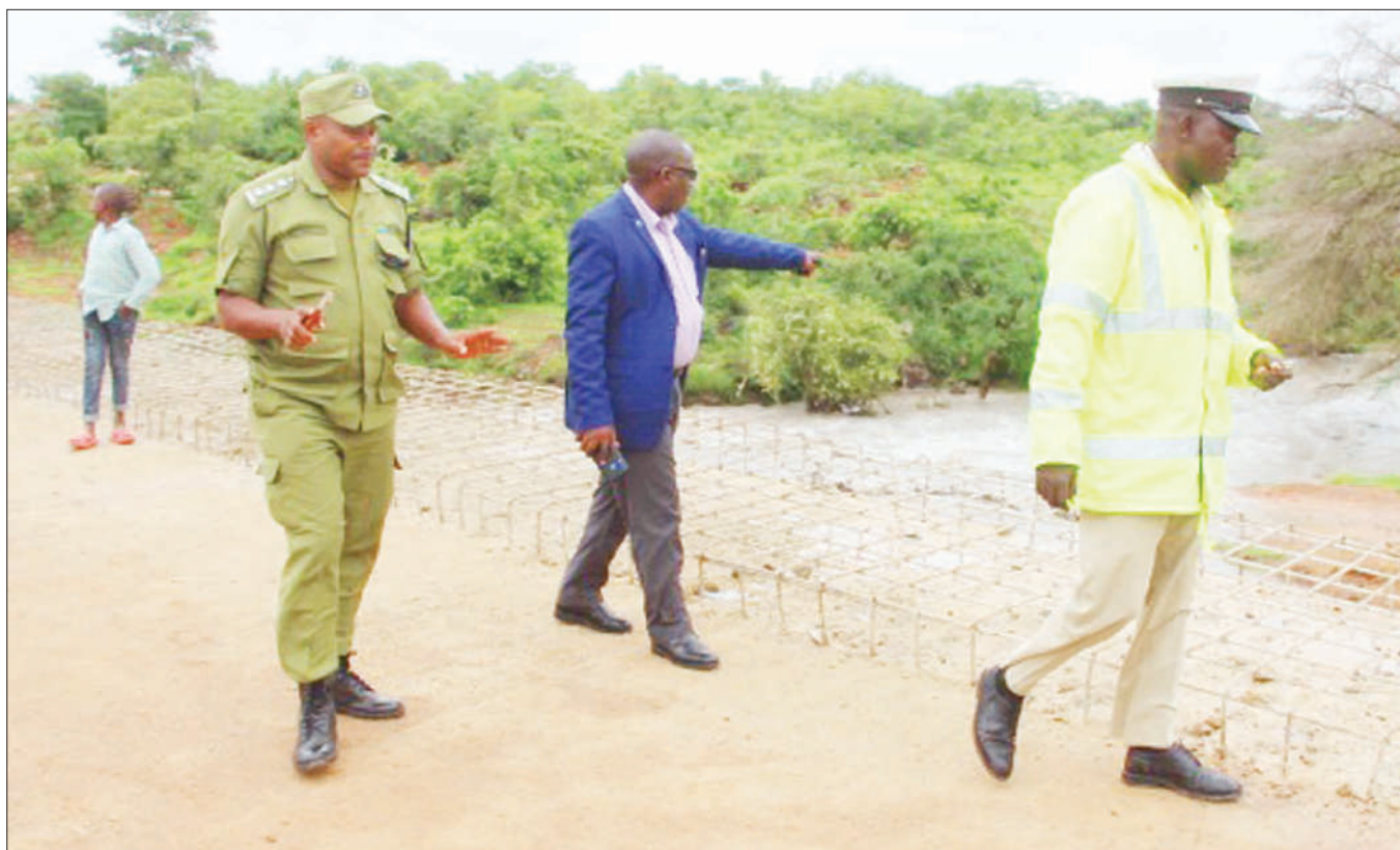
Mkuu wa Wilaya ya Chunya, Mayeka Simon (katikati), akikagua moja ya madaraja yaliyojengwa kwenye mradi wa barabara ya Chunya- Makongolosi juji. PICHA: NEBART MSOKWA
