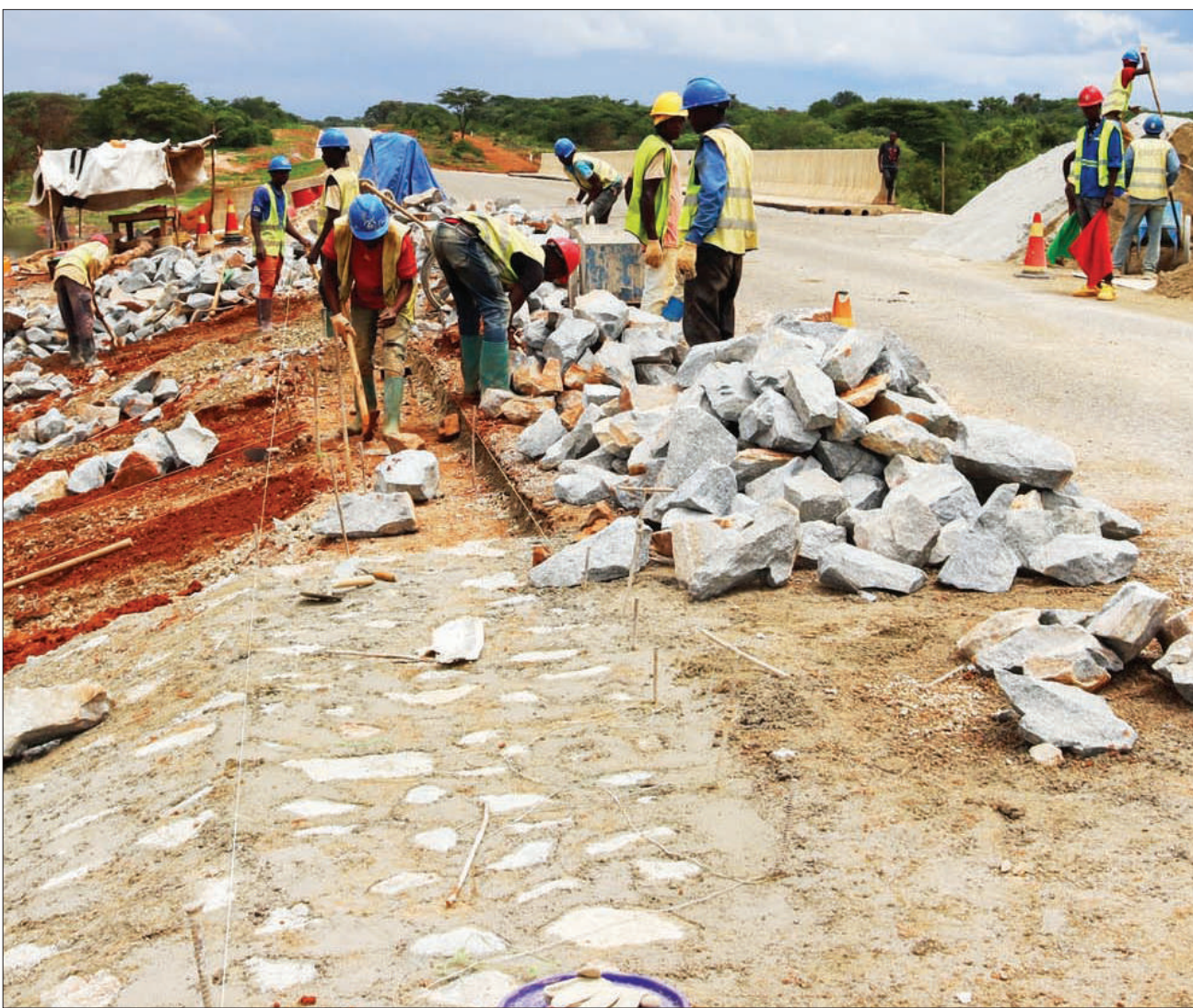
Kazi ya ujenzi wa Kingo za Daraja la Kizengi katika barabara ya Nyahua - Chaya (km 85.4), mkoani Tabora ukien-delea. PICHA: MPIGAPICHA WETU
