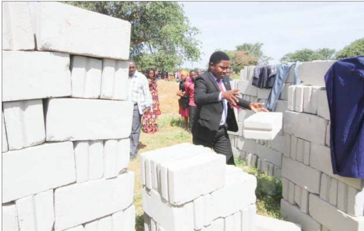
Waziri wa Nchi Ofisi ya Rais Tawala za Mikoa na Serikali za Mitaa (TAMISEMI), Selemani Jafo, akijaribu kurusha tofali chini ili kulipima uimara wake wakati akikagua maendeleo ya ujenzi wa Hospitali ya Wilaya ya Chamwino katika Kijiji cha Mlowa barabarani, Wilaya ya Chamwino mkoani Dodoma jana. PICHA: IBRAHIM JOSEPH
