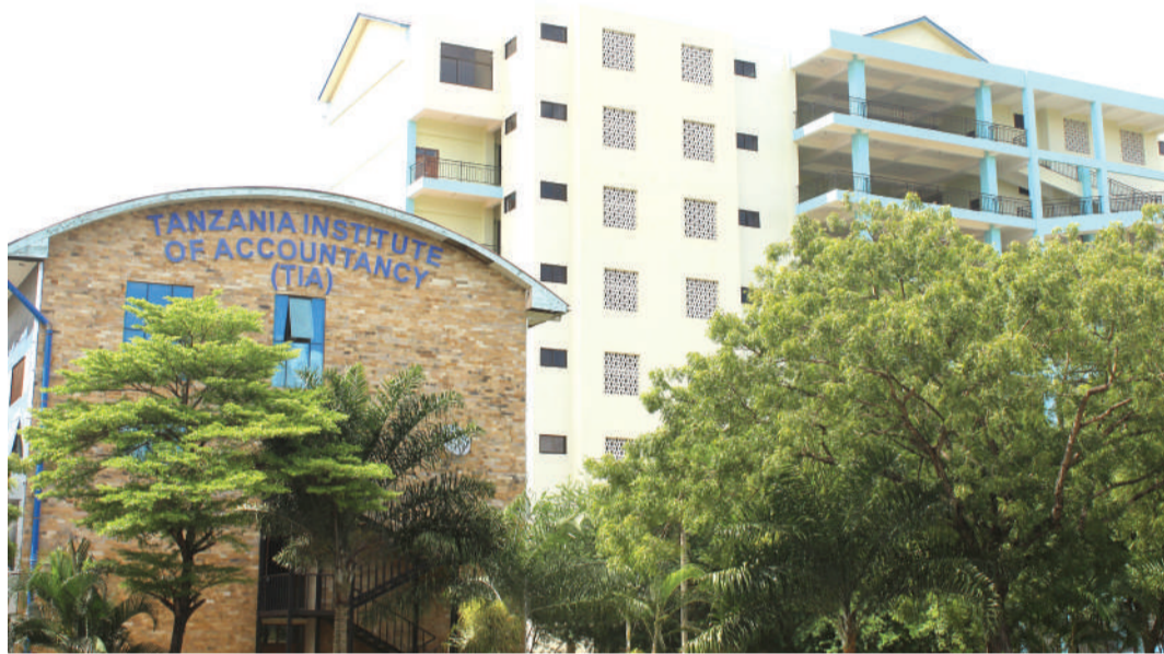
Mwonekano wa jengo la utawala na taaluma la TIA Kampasi ya Dar es Salaam.
