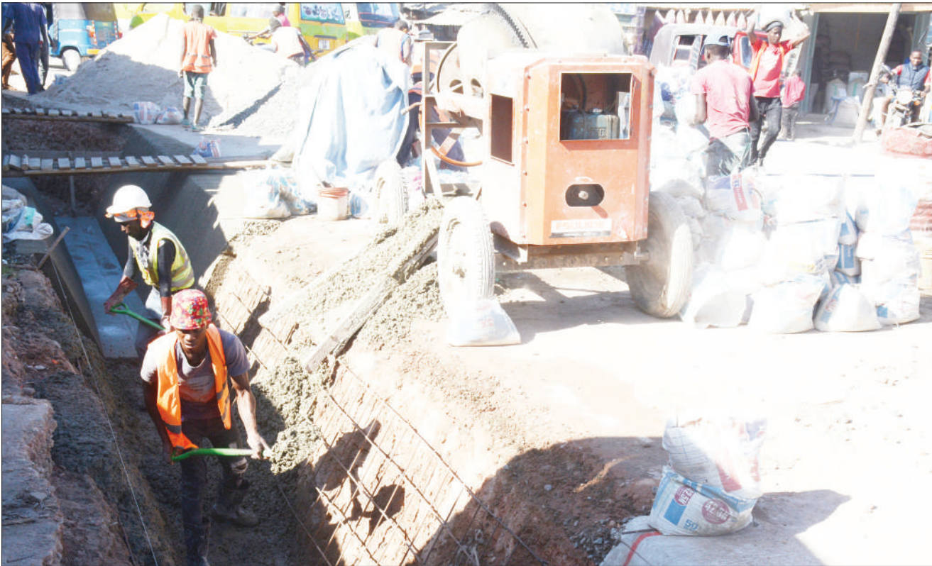
Mafundi wa kampuni ya Nyanza Road, wakiwa katika ujenzi wa mifereji ya maji ya mvua katika barabara ya Kitunda, jijini Dar es Salaam jana. PICHA: JUMANNE JUMA
