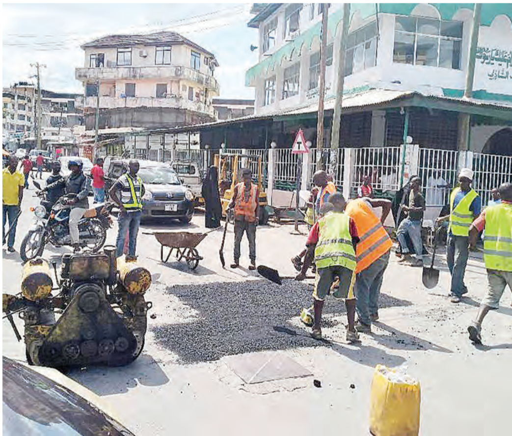
Mafundi wakikarabati kipande cha barabara kwenye makutano ya mtaa wa Sikukuu na Twiga, eneo la Kariakoo, jijini Dar es Salaam jana. PICHA: JOSEPH MWENDAPOLE
