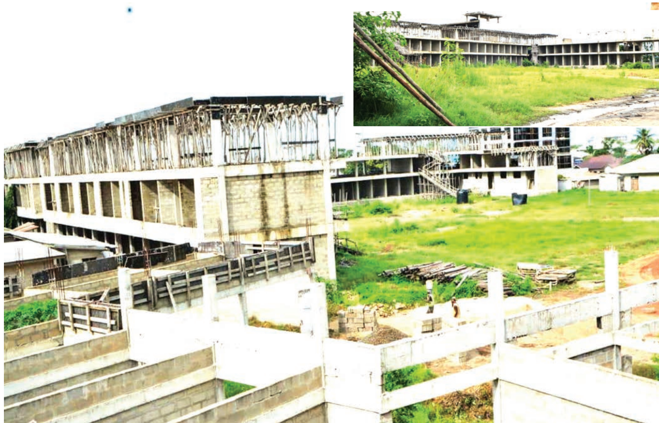
Mwonekano tofauti wa majengo ya mradi wa stendi mpya ya mabasi Mwenge, Manispaa ya Kinondoni, Dar es Salaam, ambayo ujenzi wake unaonekana kusuasua. PICHA: MIRAJI MSALA.
