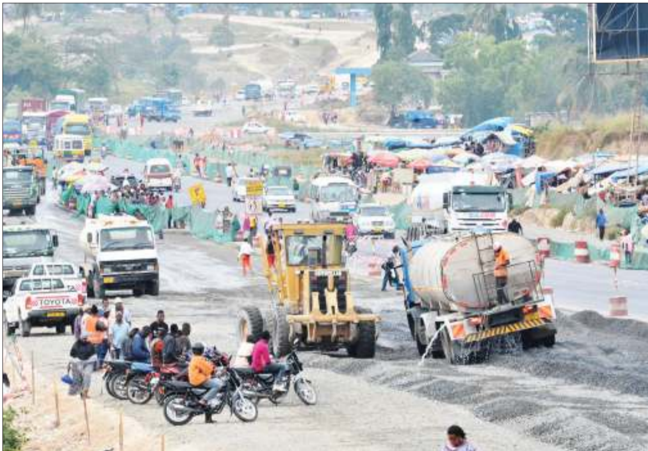
Mafundi wa Kampuni ya Estim, wakiendelea na kazi ya awamu ya upanuzi wa Barabara ya Morogoro, katika eneo la Mbezi Mwisho, jijini Dar es Salaam jana, itakayojengwa kwa njia sita kuanzia Kimara hadi Kibaha mkoani Pwani yenye urefu wa kilomita 19. PICHA: MIRAJI MSALA
