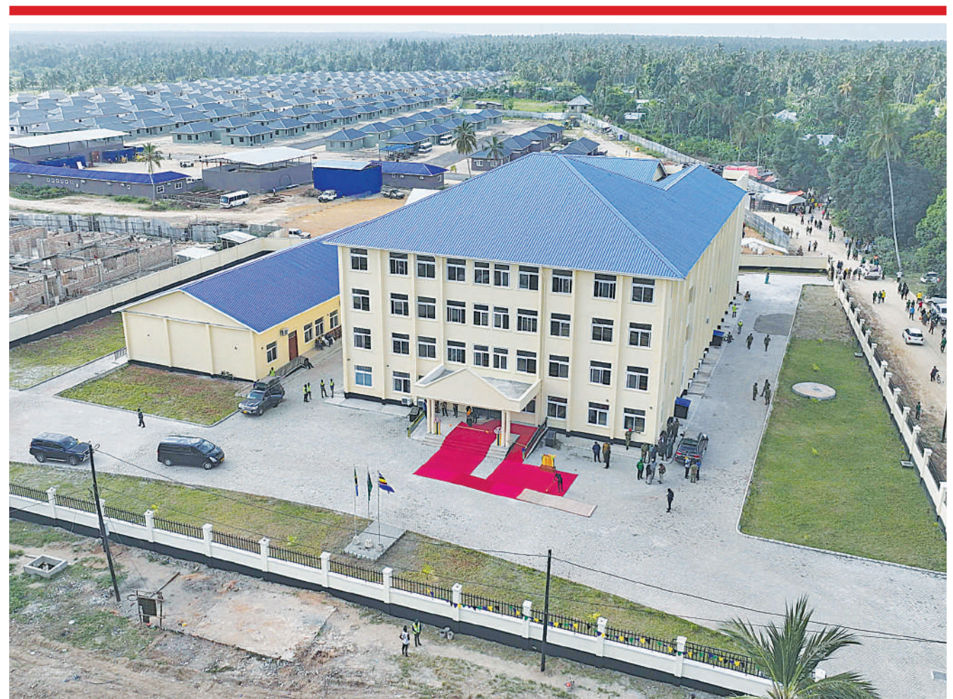
Mwonekano wa Shule ya Sekondari Misufini iliyoko Bumbwini, Zanzibar baada ya kufunguliwa na Rais Dk. Samia Suluhu Hassan jana. PICHA: IKULU
