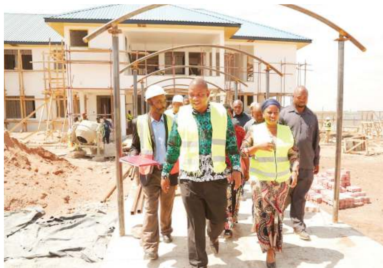
Waziri wa Afya, Ummy Mwalimu (kulia), akiwa na Mkuu wa Mkoa wa Simiyu, Anthony Mtaka (kushoto) wakikagua mojawapo ya majengo ya Hospitali ya Rufaa ya mkoa wa Simiyu ambayo inajengwa katika kipindi hiki cha miaka minne ya Rais Magufuli. PICHA ZOTE: MTANDAO
