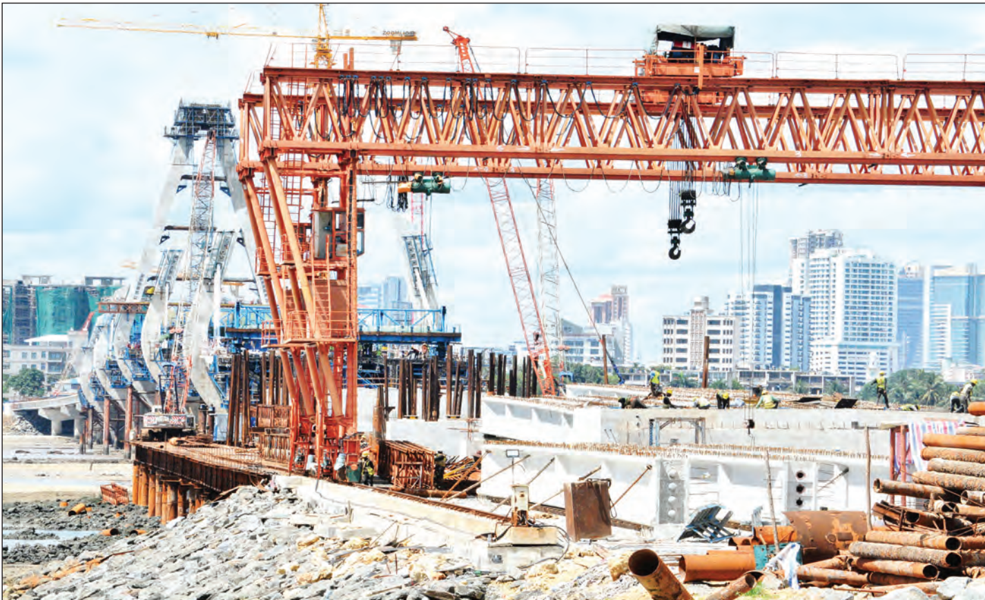
Mkandarasi akiendelea na ujenzi wa daraja jipya la Tanzanite, linalounganisha maeneo ya Aga Khan Upanga Mashariki na Oysterbay kupitia Bahari ya Hindi, jijini Dar es Salaam jana. PICHA: MIRAJI MSALA
