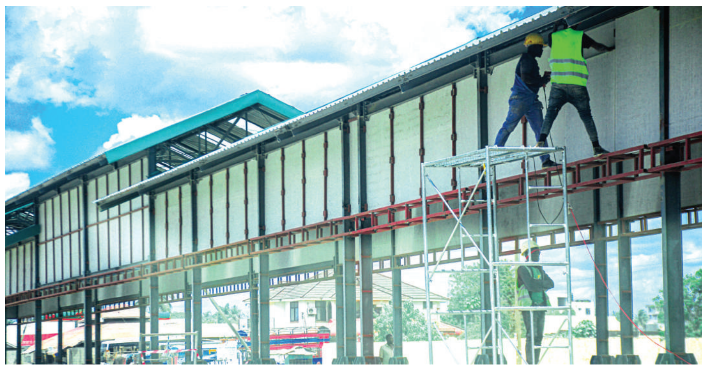
Mafundi wa Kampuni ya Sino, wakiendelea na ujenzi wa kituo cha mabasi yaendayo haraka (BRT), katika Barabara ya Kilwa, Mtoni Mton-gani mkoani Dar es Salaam jana. PICHA: JUMANNE JUMA
