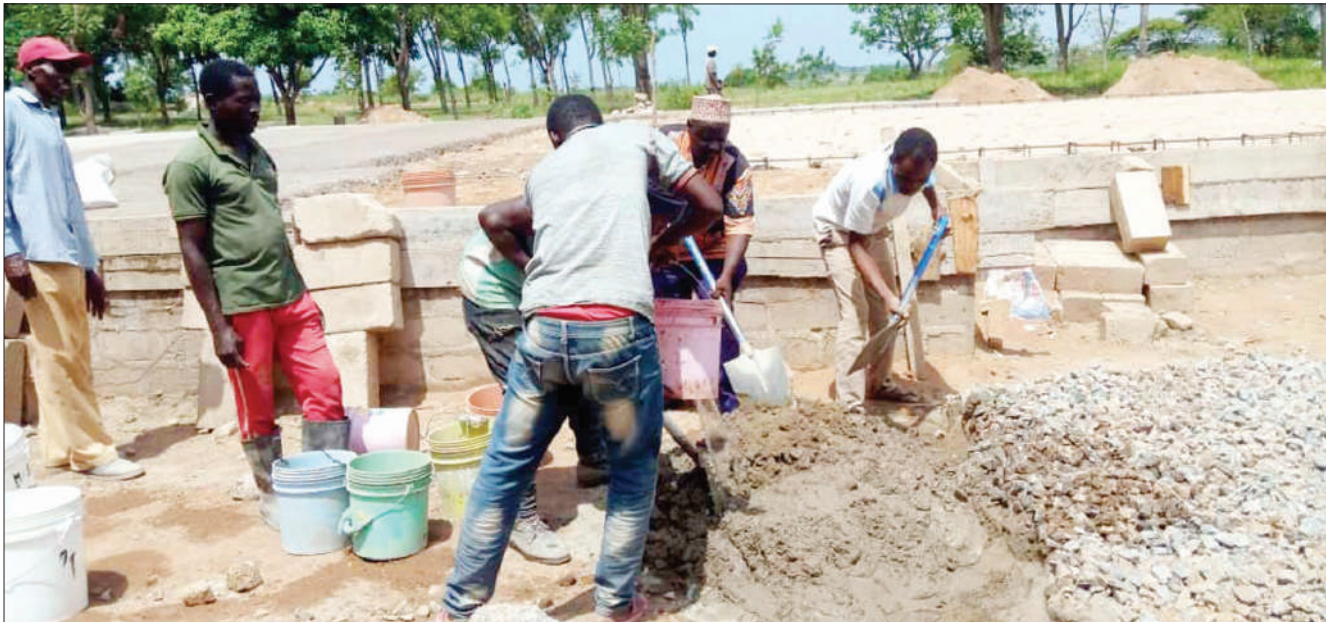
Mafundi wakichanganya zege kwa ajili ya ujenzi wa jengo la utawala la Shule ya Sekondari Kiriba iliyopo Wilaya ya Musoma mkoani Mara, juzi. Kwa mujibu wa Mkuu wa Shule hiyo, Paul Mtani (hayupo pichani), serikali imetoa Sh. milioni 50 kuchangia ujenzi na uboreshaji wa miundombinu ya shule hiyo. PICHA: MPIGAPICHA WETU
