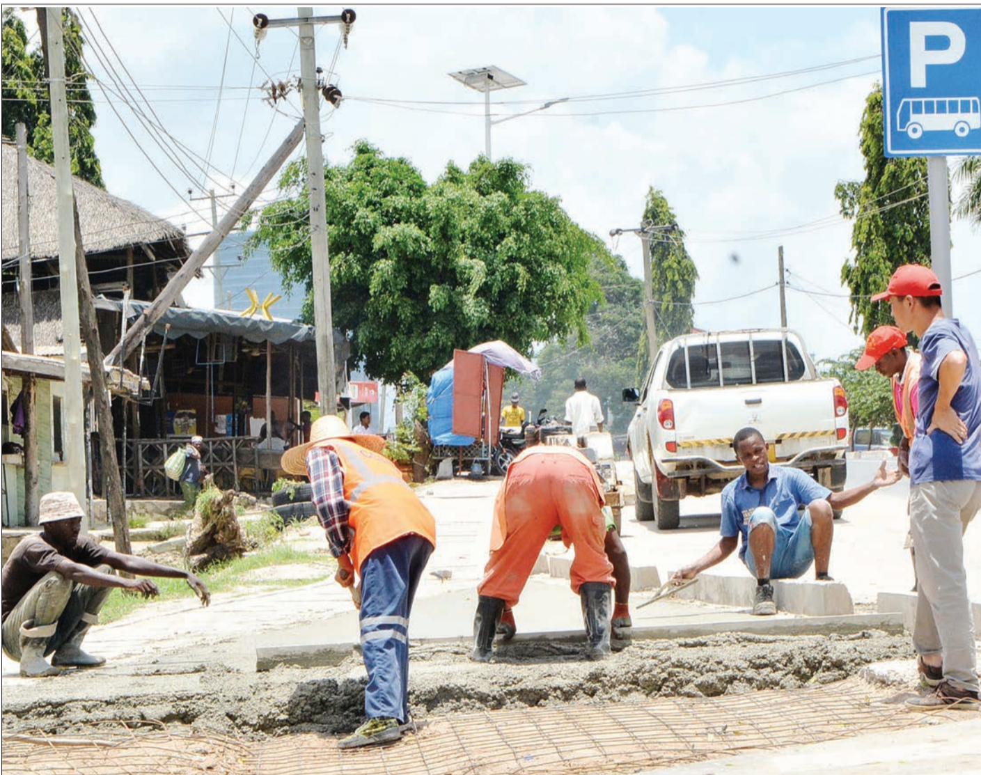
Mafundi wakiendelea na kazi ya kujenga vituo vya daladala, katika Barabara ya Sinza Kijiweni-Tandale, katika eneo la Tandale, jijini Dar es Salaam mapema wiki hii. PICHA: MIRAJI MSALA
