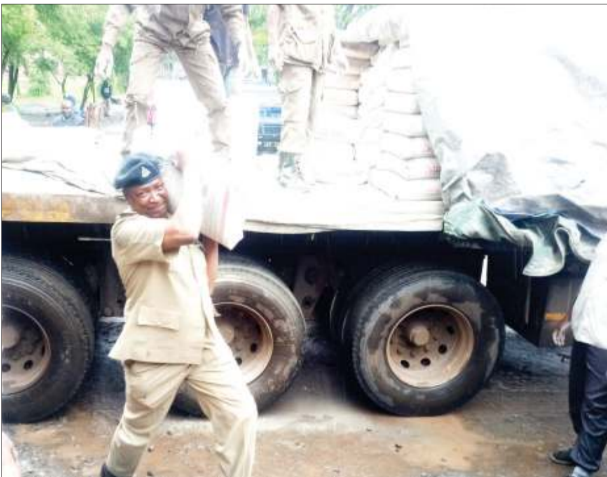
Mkuu wa Polisi wa Wilaya ya Hai, SSP Lwelve Mpina, akishiriki kupakua mifuko 200 ya saruji, iliyotolewa msaada kwa ajili ya upanuzi wa Kituo Kikuu cha Polisi cha wilaya hiyo, (Bomang'ombe), juzi. PICHA: GODFREY MUSHI
