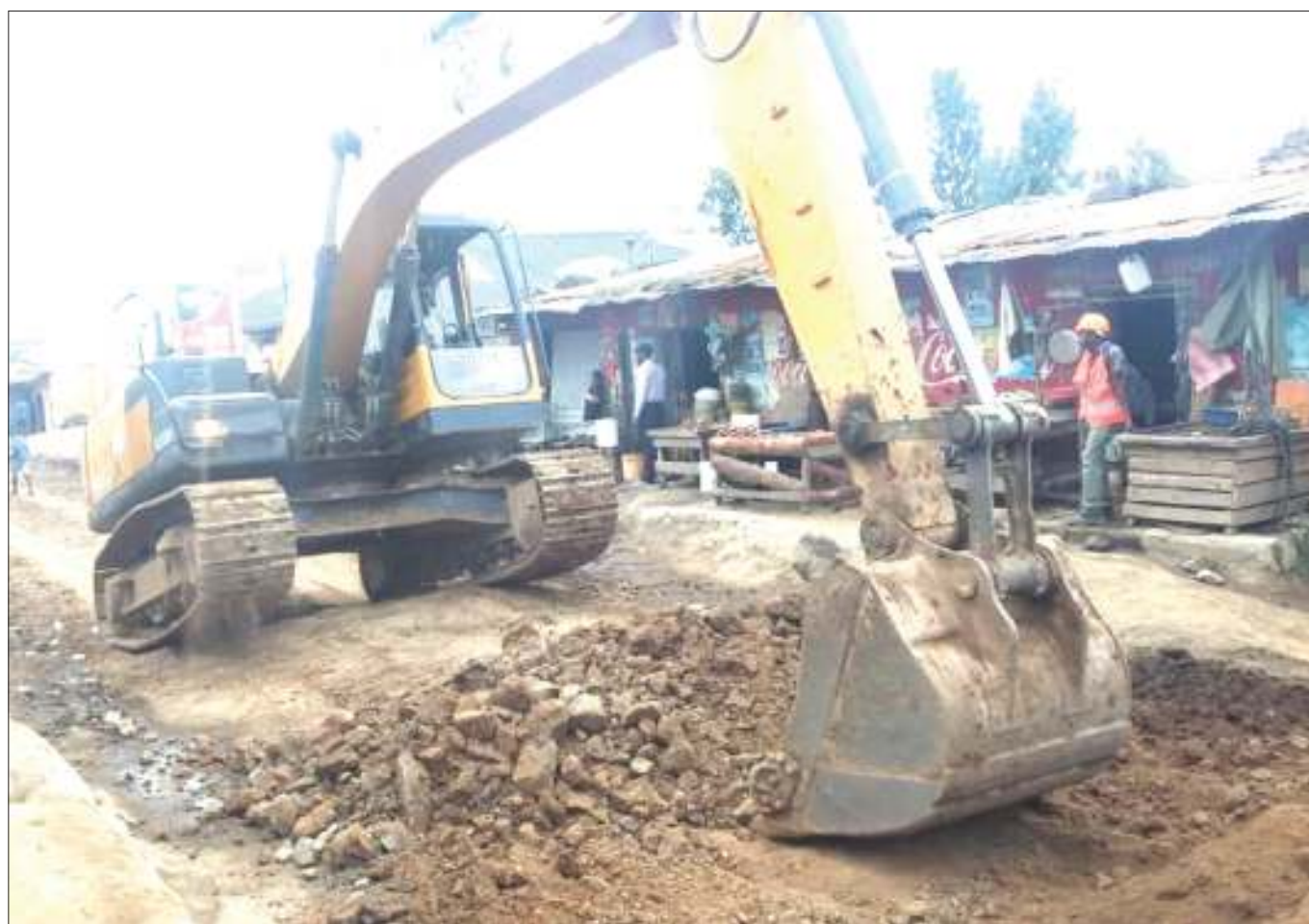
Kijiko cha kampuni ya ukandarasi kikiendelea na ujenzi wa barabara ya kuanzia Mama John hadi Mwakibete, jijini Mbeya juzi. Ujenzi huo, ukikamilika utasaidia kupunguza msongamano wa magari kwenye barabara kuu ya Tanzania na Zambia. PICHA: NEBART MSOKWA
