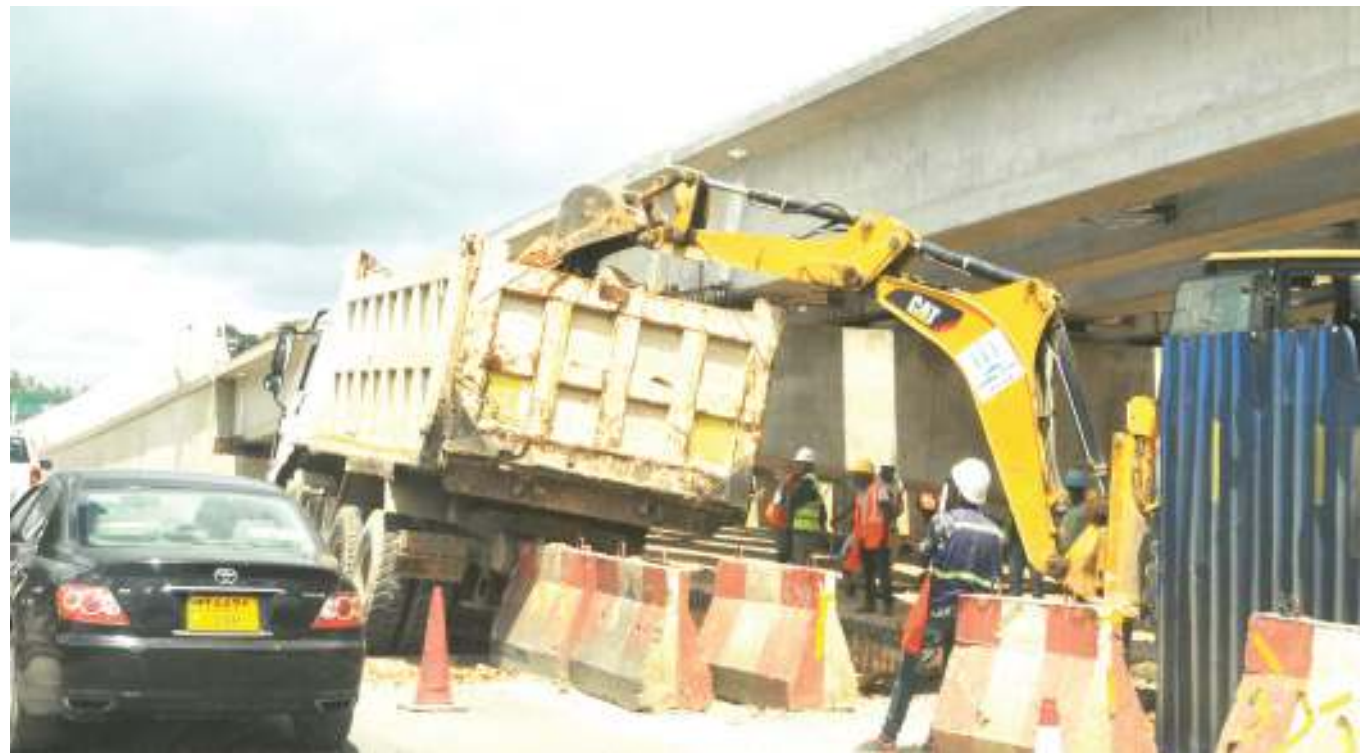
Mafundi wakiendelea na ujenzi wa barabara za mpishano (Ubungo Interchange), katika makutano ya Barabara za Morogoro, Mandela na Sam Nujoma, eneo la Ubungo, jijini Dar es Salaam jana. Picha: JOHN BADI
