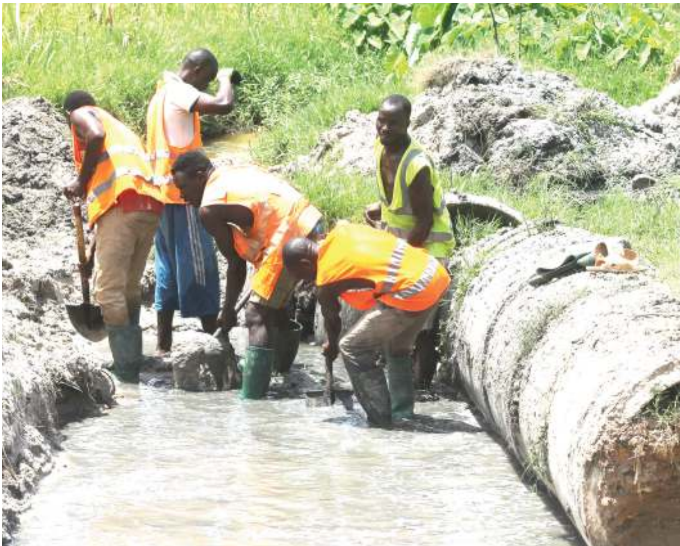
Mafundi wa kampuni ya ujenzi ya Nyanza Road, wakichimba mtaro kwa ajili ya kutoa karavati za zamani ili waweke mpya katika Barabara ya Kitunda, jijini Dar es Salaam jana. PICHA: JUMANNE JUMA
