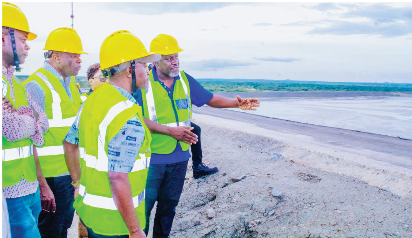
Mhandisi Mkuu wa Mgodi wa Almasi wa Mwadui, Shaghembe Mipawa, akiwaonyesha Wajumbe wa Kamati ya Kudumu ya Bunge Nishati na Madini bwawa jipya la kuhifadhia majitope la mgodi huo, ambalo kwa sasa wanalitumia katika shughuli za uzalishaji almasi baada ya lile la mwanzoni kubomoka kingo zake. PICHA: MARCO MADUHU
