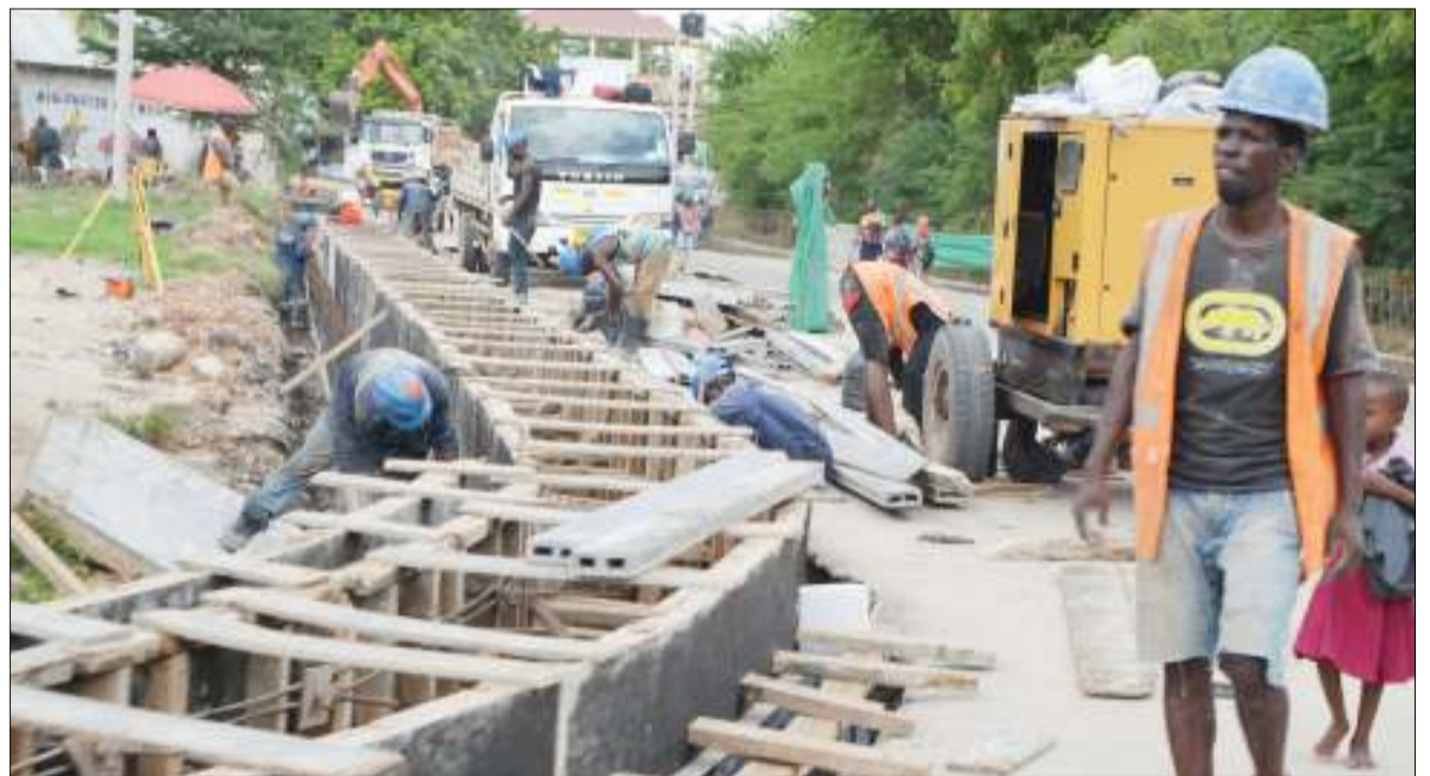
Mafundi wa kampuni ya ujenzi ya CCECC, wakiendelea na ujenzi wa mitaro ya maji ya mvua katika Barabara ya Tandale, jijini Dar es Salaam jana. Picha: MIRAJI MSALA
