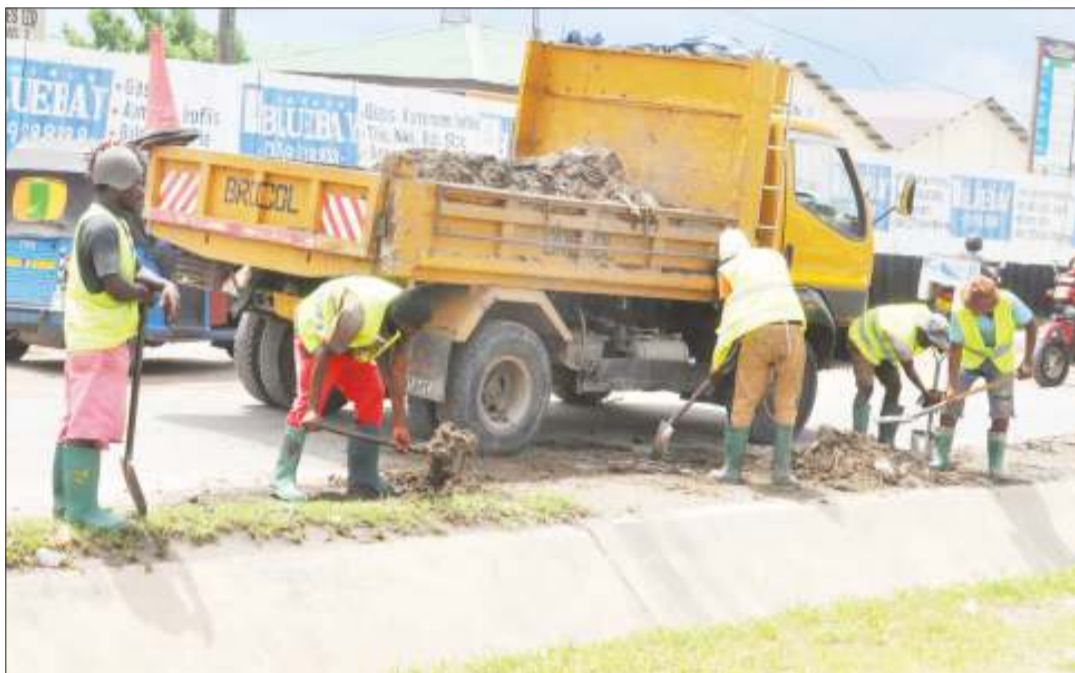
Wafanyakazi wa kampuni ya usafi ya Brecol wakizoa udongo uliotolewa kwenye mitaro ya maji ya mvua kando ya Barabara ya Mandela, eneo la Buguruni Al Hamza, jijini Dar es Salaam jana. PICHA: JOHN BADI
