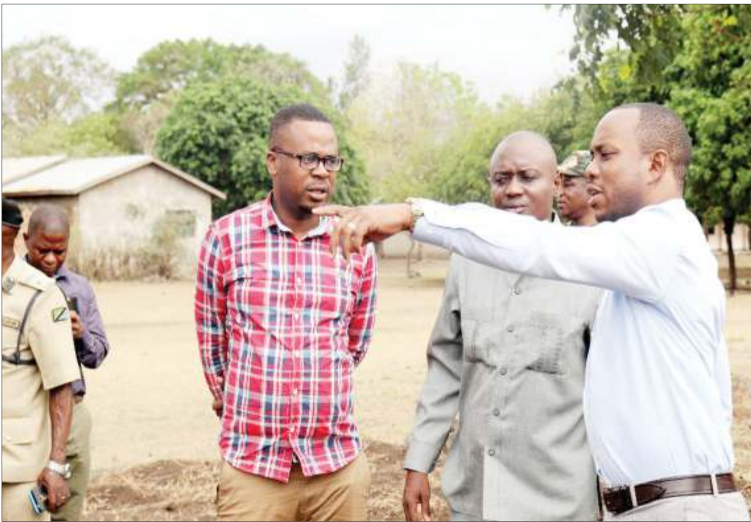
Mkuu wa Mkoa wa Arusha, Mrisho Gambo (katikati), akipata maelezo kutoka kwa Mkuu wa Wilaya ya Arumeru, Jerry Muro, kuhusu maendeleo ya ujenzi wa kituo cha ukaguzi wa watalii kinachojengwa wilayani humo juzi. PICHA: WOINDE SHIZZA
