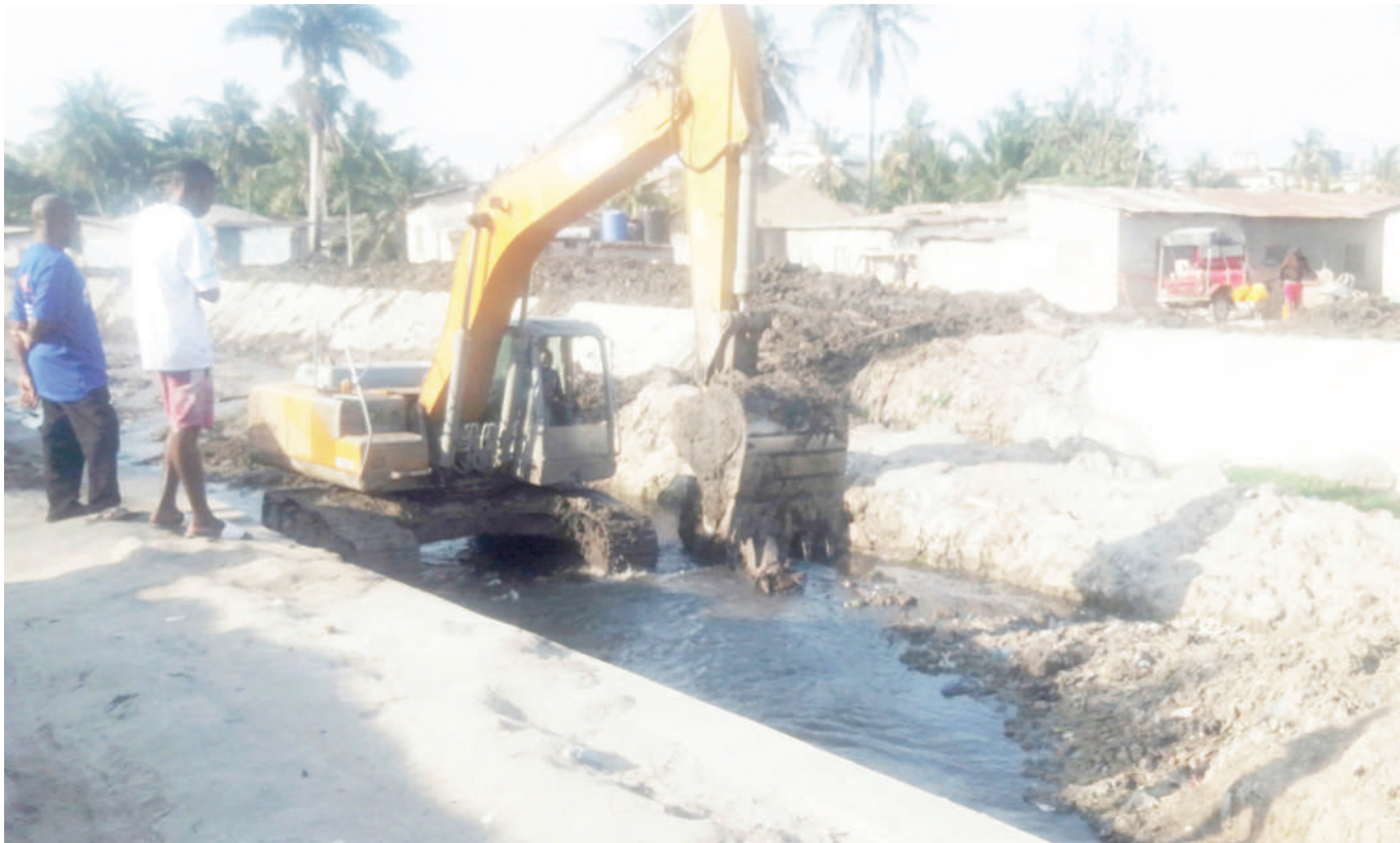
Mkandarasi akiendelea na kazi ya kutoa mchanga kwenye Mto Ng'ombe eneo la Tandale mkoani Dar es Salaam jana, baada ya ujenzi wa kuta za kingo za mto huo. PICHA: VICTORIA MGDOMI, TUDARCO
